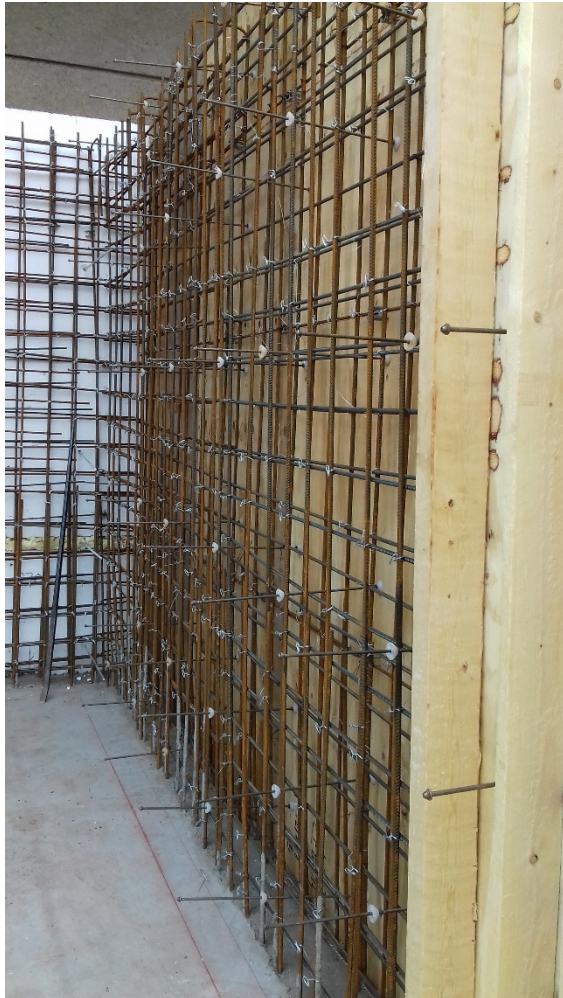
KUVA 1. Raudoitettu seinämuotti (Seppänen Toukokuu 2017)
