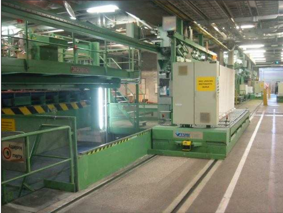
Kuva 4. Lavojen siirto pakkaukseen
