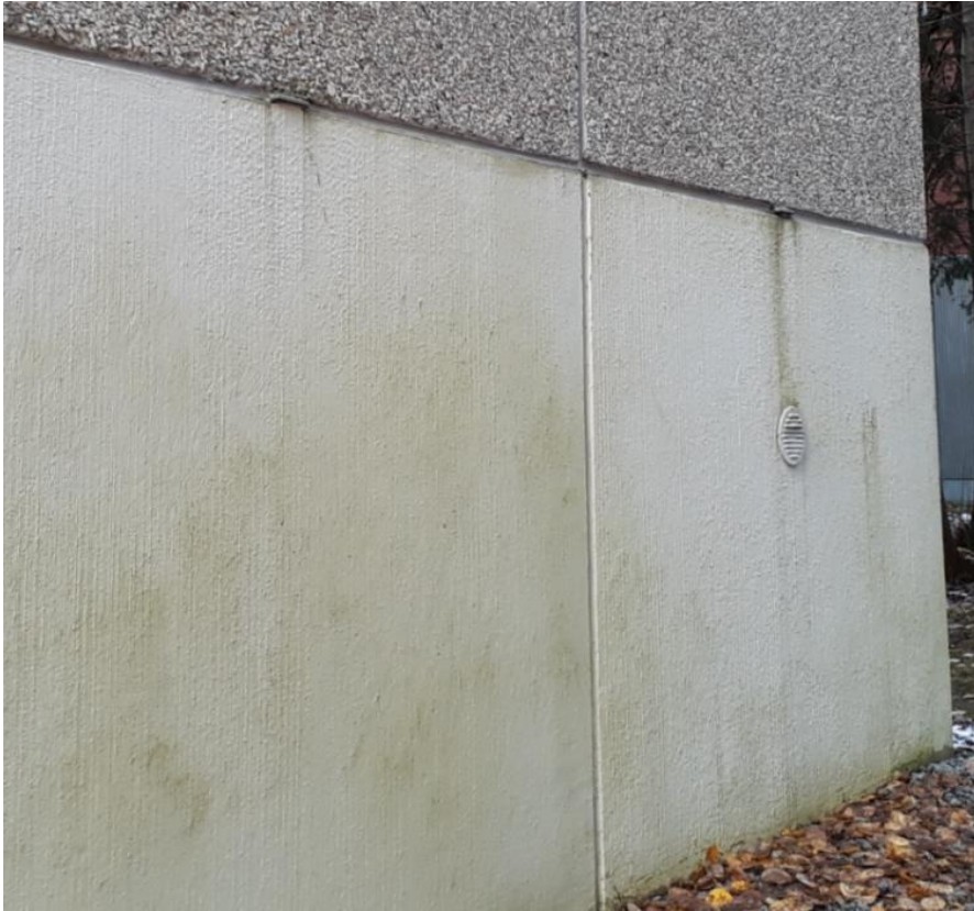
KUVA 8. Kohteen 7 julkisivun perusmuuri
