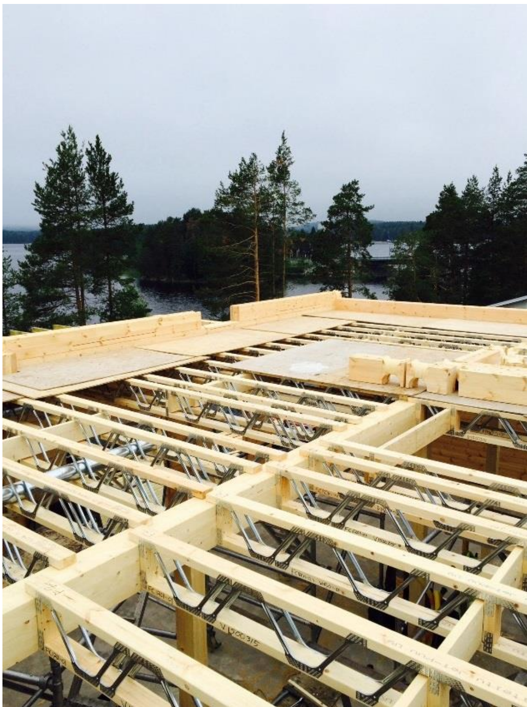
Kuva 14. Kaksikerroksisissa rakennuksissa välipohjan kantavien rakenteiden asentaminen mahdollistaa turvallisen työskentelyn. Posi-palkki välipohja voidaan päällystää asennustyön ajaksi esimerkiksi vanereilla. (Musakka 2015-07-07)
