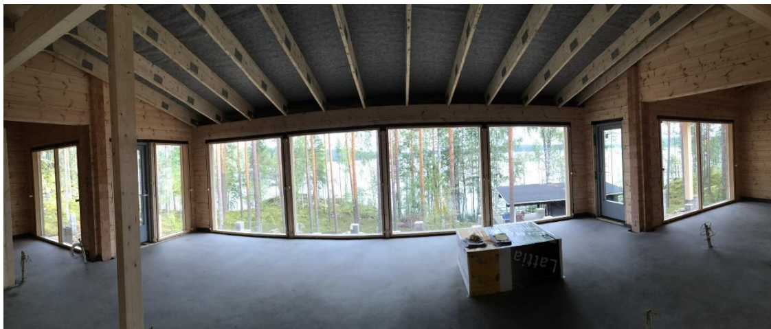
Kuva 8. Asiakkaalle luovutettava urakkarajan mukainen valmis tila (Musakka 2016-01-09)
