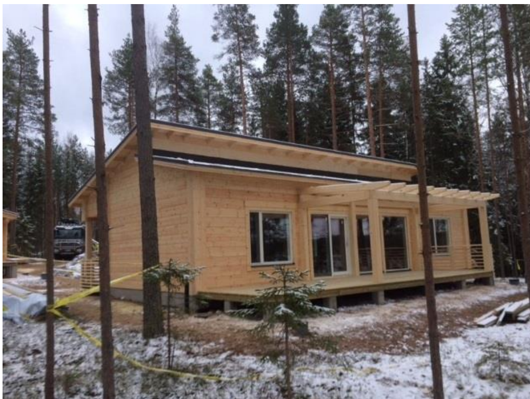
Kuva 11. Honkarakenne L-urakkalaajuuden mukainen valmiusaste. Ympäristö siivottu luovuttamista varten, asiakkaan toiveena oli myös pitää ympäristö koskemattomana. Työmaa-alue rajattu huomioväri siimalla. (Musakka 2016-10-11)
