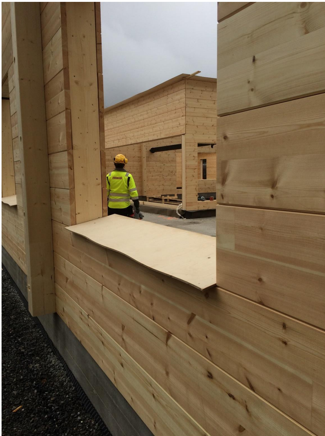
Kuva 4. Aukkojen varaukset on suojattu vanereilla vedenkertymisen estämiseksi ja ohjaamiseksi ulospäin rakenteesta. (Musakka 2017-04-09)
