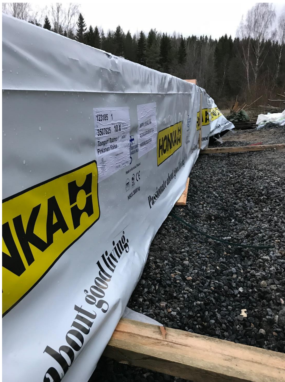
Kuva 2. Työmaalla hirret varastoidaan irti maasta käyttäen alus/telapuita. Ilmankierto on varmistettava pakkauksen päädissä. (Musakka 2017-11-10)
