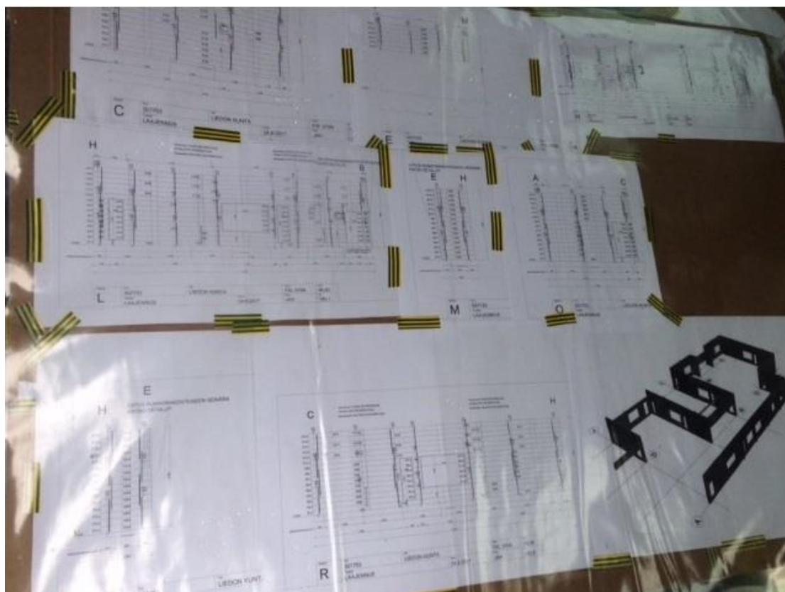
Kuva 19. Hirsiasennuksen aikana seinälinjapiirustuksia tulisi olla työmaalla ainakin kahdet kappaleet. Piirustukset on suositeltavaa suojata kastumiselta ja asetella siten, että jokainen seinälinja on asentajalle nopeasti luettavissa. (Musakka 2017-09-09)
