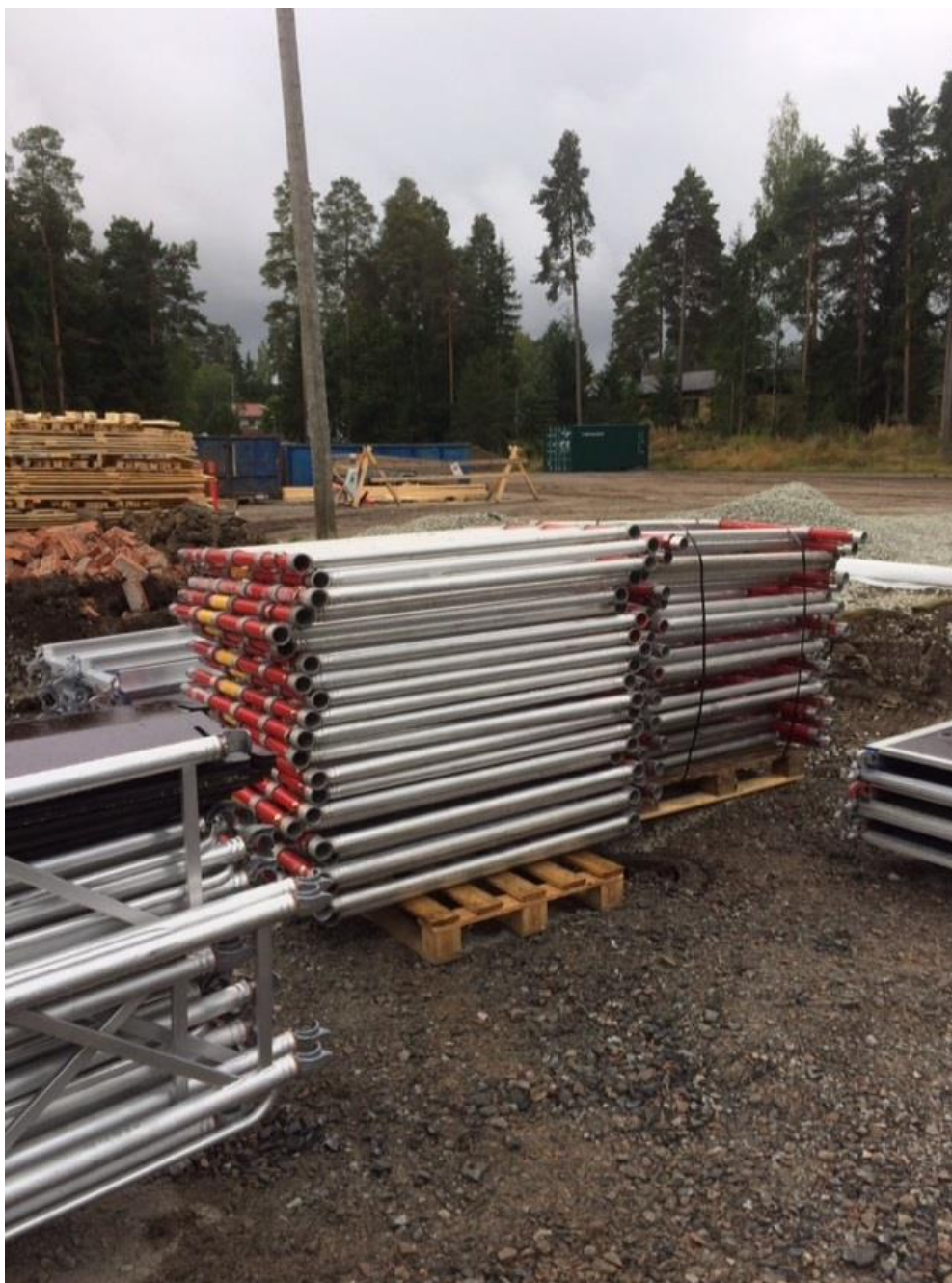
Kuva 10. Telinekalustolle varataan tilaa varastointiin ja säilytys tapahtuu trukkilavojen päällä. Telineet säilyvät puhtaana ja siirtäminen nosturilla nopeutuu. (Musakka 2017-09-09)
