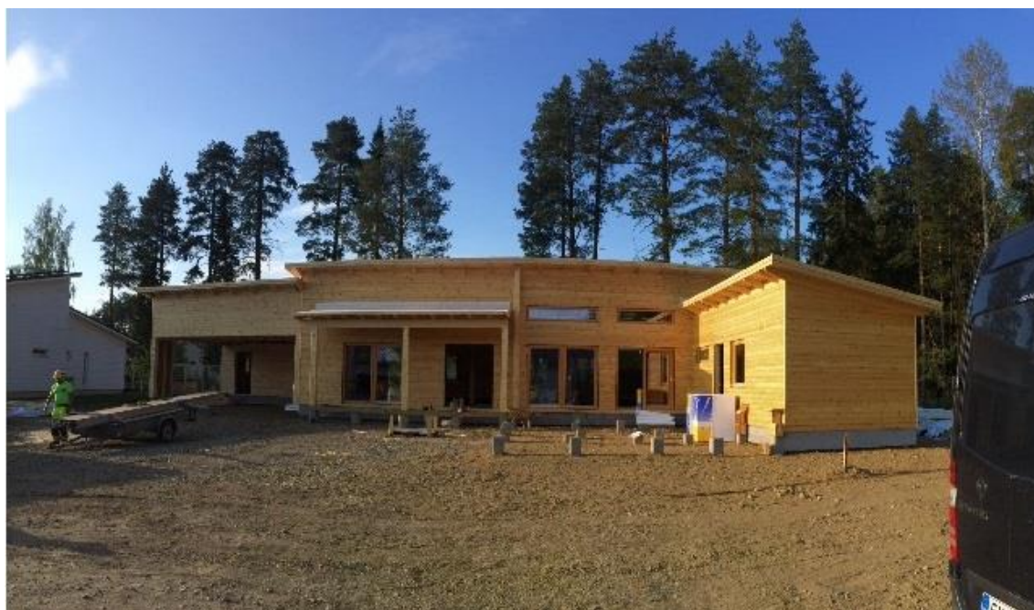
Kuva 12. Honkarakenne M-urakan mukainen valmiusaste. Kohde valmiina asiakkaalle luovutusta varten. (Musakka 2016-05-05)
