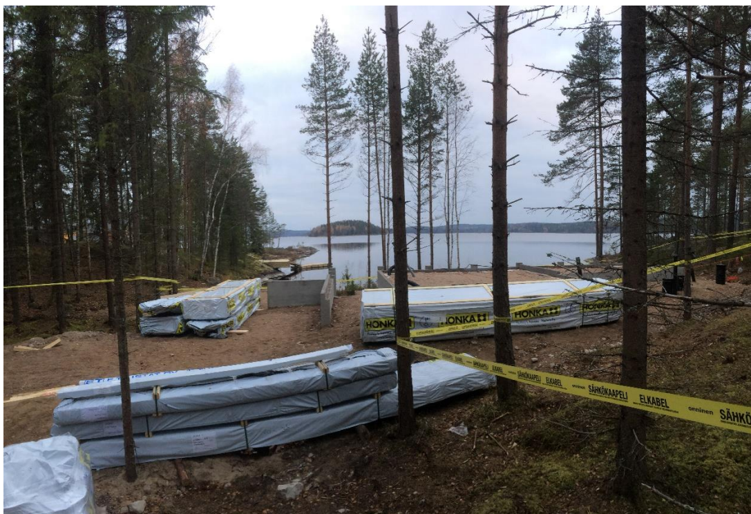
Kuva 17. Esimerkki materiaalipakettien järjestelystä perustusten ympärille. (Musakka 2016-09-06)
