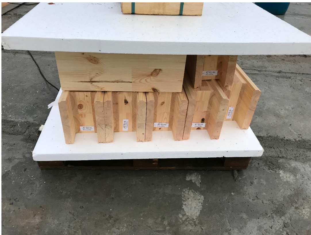
Kuva 3. Pienet hirret voidaan suojata esimerkiksi vaneri- tai styroksilevyillä. Ilmankierto sivuille toteutuu näin tehokkaasti. (Musakka 2017-11-10)
