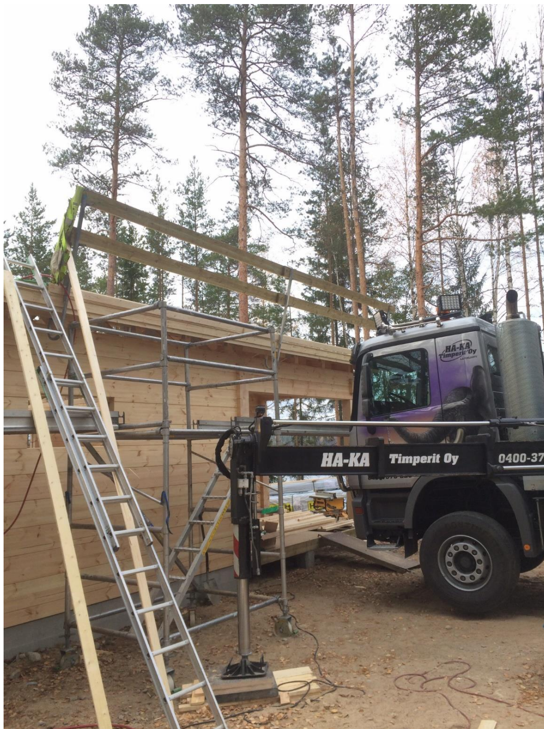
Kuva 13. Kattotoissa putoamissuojana käytetään suojakaiteita tai turvavaljaita (Musakka 2016-05-11)
