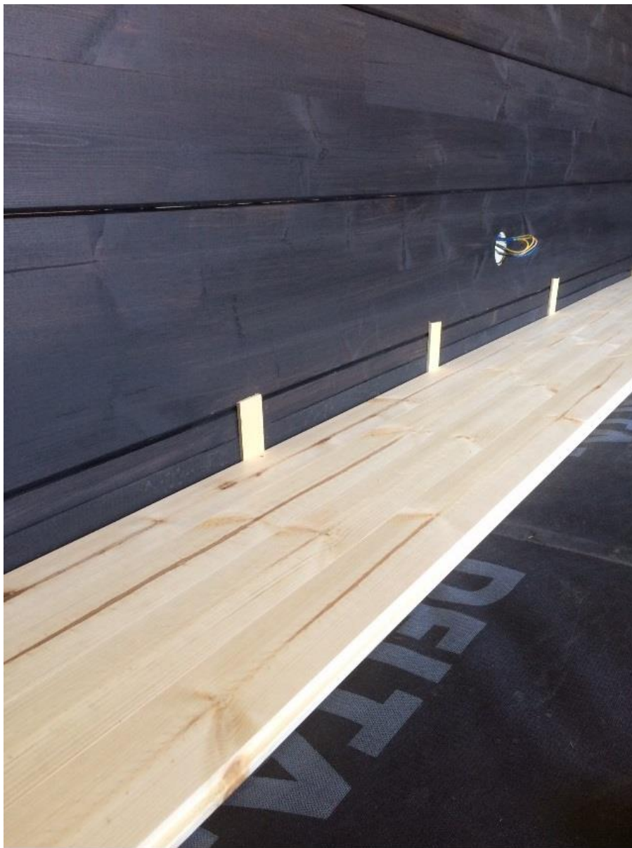
Kuva 9. Asennettaessa lattian pintamateriaalia tulee alustan puhtauteen kiinnittää erityistä huomiota. (Musakka 2017-06-06)
