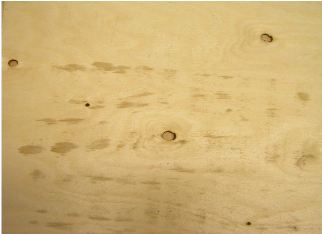
Kuva 7. Vesilasin valumajäljet alustassa
