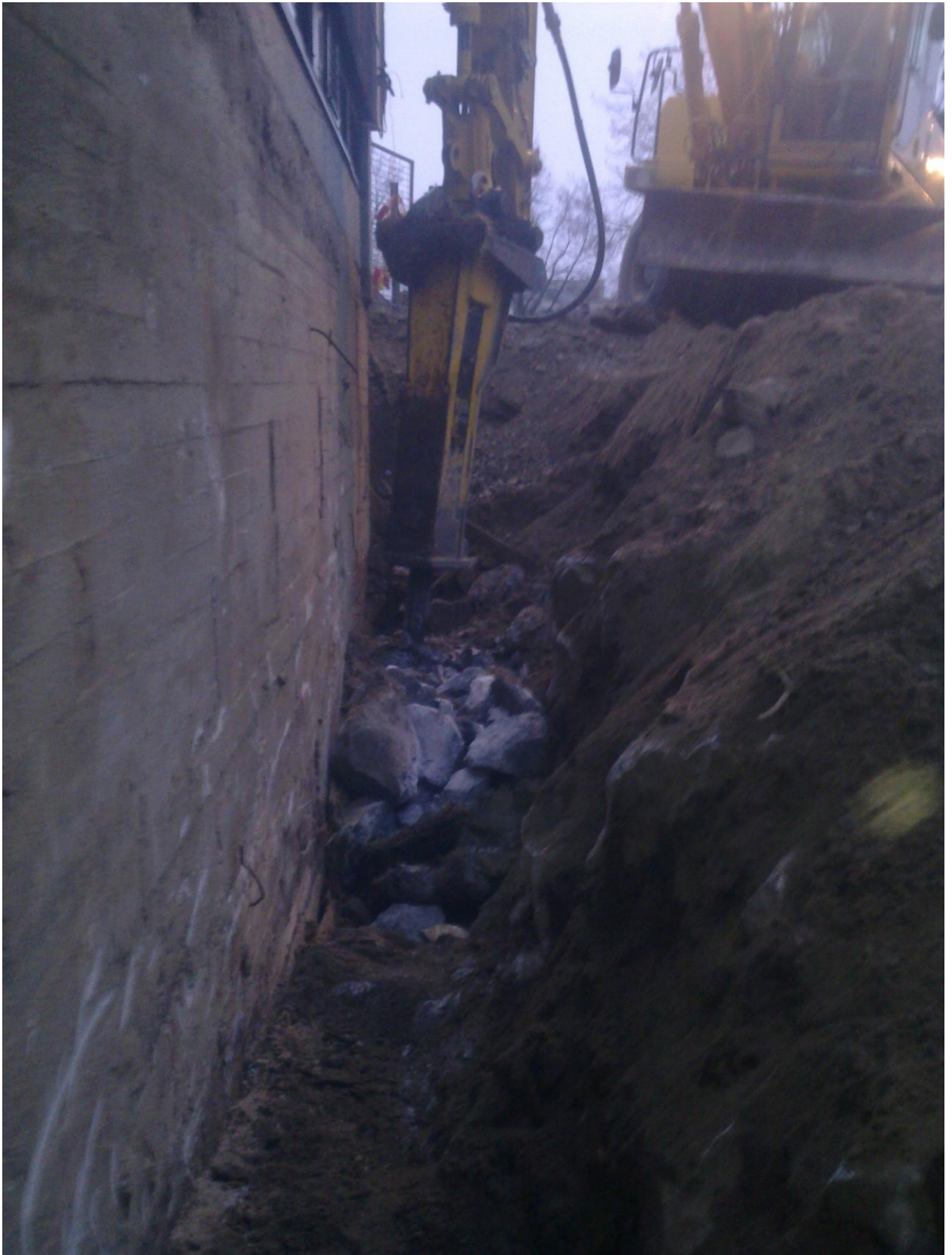
Kuva 9. Kallion piikkausta kaivinkoneeseen kiinnitettävällä iskuvasaralla
