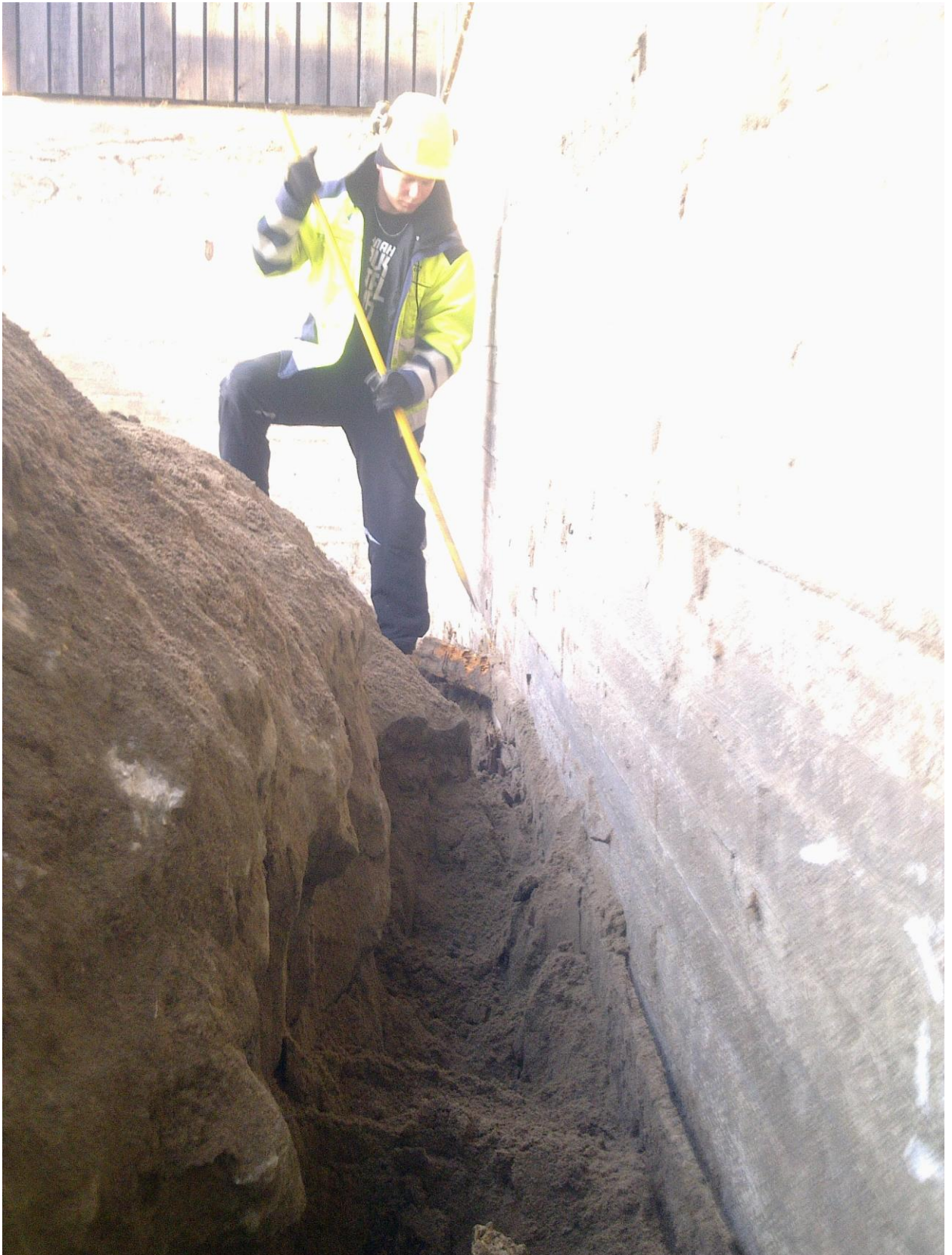
Kuva 8. Maankaivu perustustasoon kallion ja perusmuurin välistä
