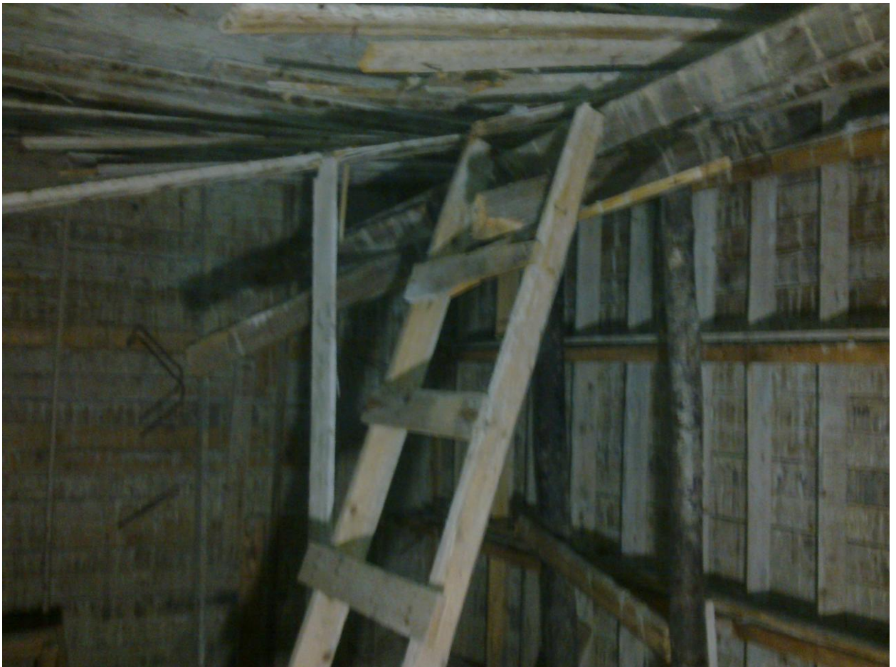
Kuva 16. Ns. rakentamattomassa tilassa paikoillaan olevat muottilaudoitukset
