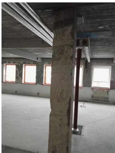
Kuva 9 Takana näkyy ikkunan alalinjaan kapseloitu ulkoseinä. Lattiasa tiivistettyjä välipohjan läpivientejä (Juvonen 2017).
