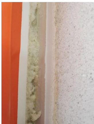
Kuva 29 Ikkuna tiivistettiin ensin uretaanivaahdolla. Tässä vaiheessa teipattiin myös raja tiivistyspinnotteelle turhan sotkun välttämiseksi (Juvonen 2017).
