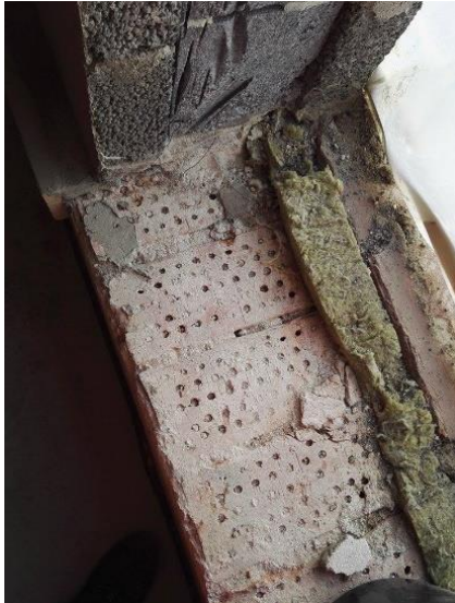
Kuva 34 Irrotetun mosaiikkibetonitason alla on huokoinen tiilialusta. (Juvonen 2017)
