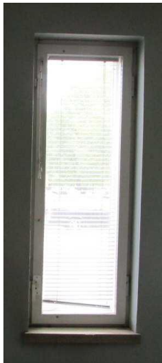
Kuva 24 Vanha puuikkuna, jossa mosaiikkibetonitaso (Työselitys)
