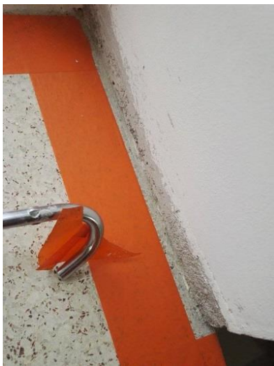
Kuva 35 Mosaiikkibetonitasojen liittymät ulkoseiniin tiivistettiin. Kuvassa rajausteippi ylimääräisen sotkun vähentämiseksi. (Juvonen 2017)
