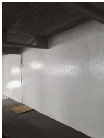
Kuva 14 Valmiiksi kapseloitu vanha ulkoseinäpinta (nyk. väliseinä). Seinän ja välipohjan liitos on taitettu pintatasoitteen alle (Juvonen 2017).
