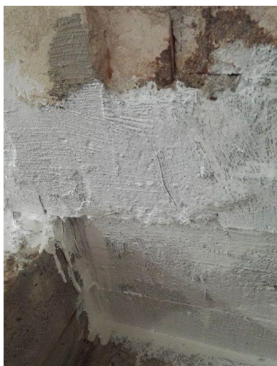
Kuva 12 Tiivistys tehtynä uuden lattiarakenteen kohdalla. Valkoinen hyytelön väri erottaa mahdolliset raot hyvin (Juvonen 2017).
