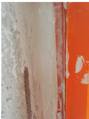
Kuva 31 Ikkuna tiivistettiin tiivistykseen sopivalla pinnoitteella. (Juvonen 2017)
