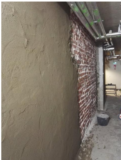
Kuva 5 Osittain purettu vanha ulkoseinä rapataan ja kapseloidaan (Juvonen 2017).
