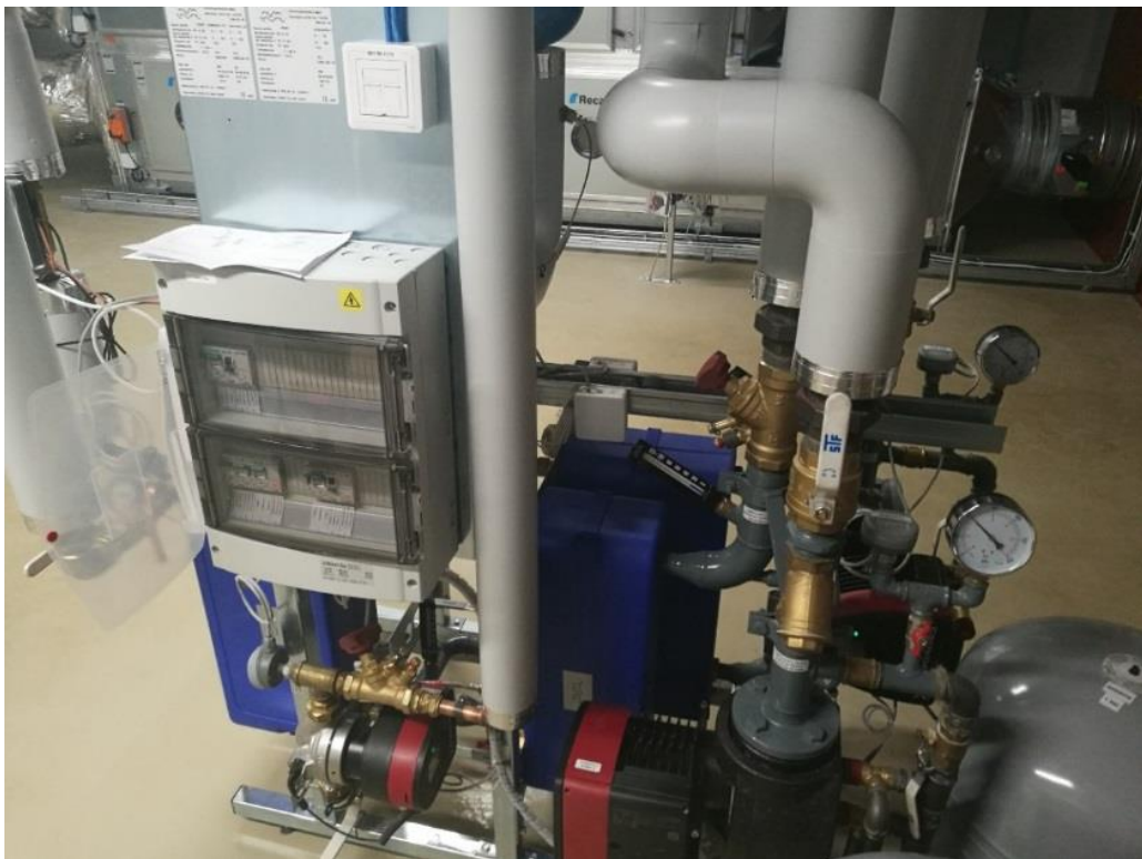
Kuvio 20. Kaukolämmönvaihdinpaketti
