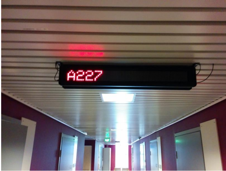
KUVA 25. Käytävänäytön asennus kattoon
