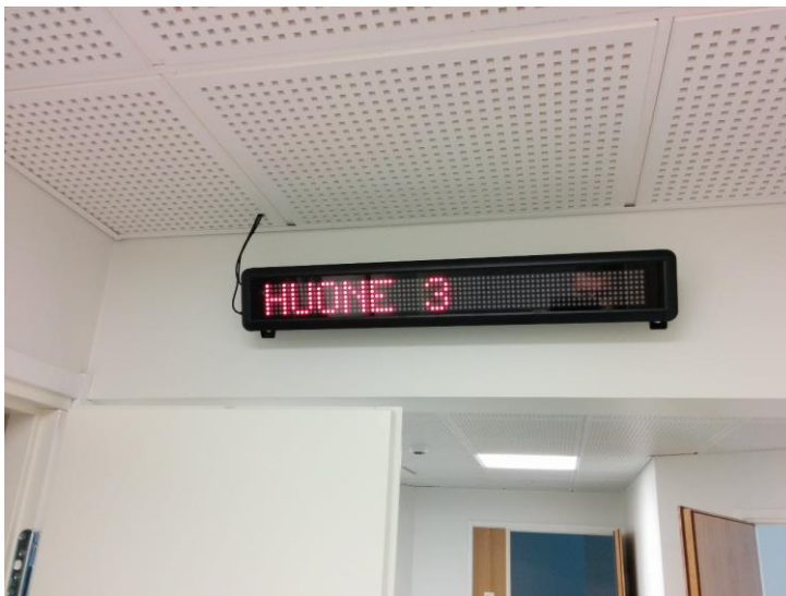
KUVA 26. Käytävänäytön asennus seinään
