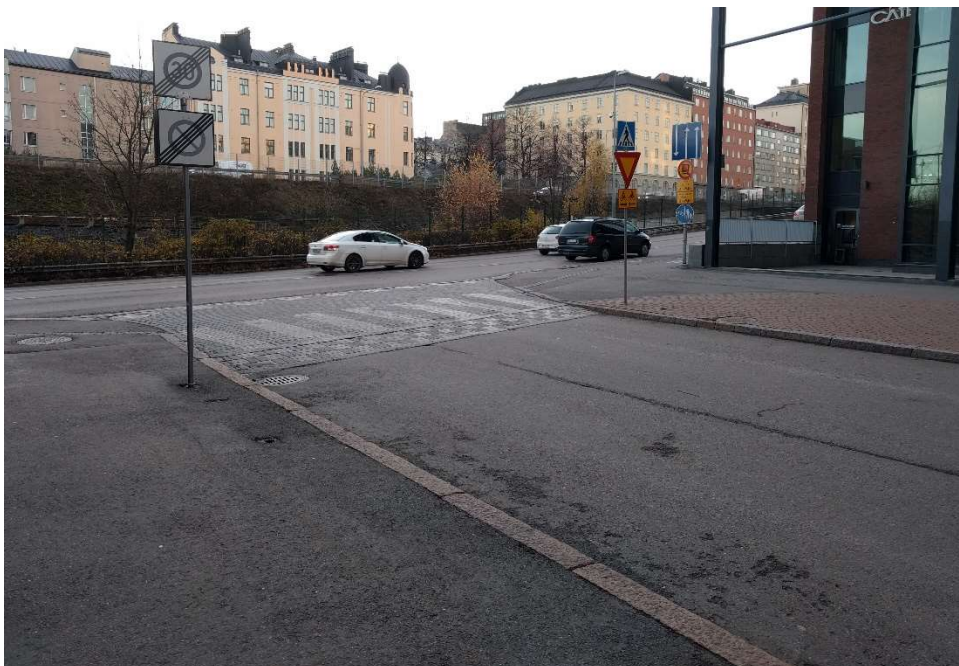
Kuva 41. Nykyisessä järjestelyssä näkymä risteykseen on parempi, kun pysäköintiruutuja poistettiin risteyksen välittömästä läheisyydestä. Toisaalta jakeluautot käyttävät tilaa edelleen pysäköintiin.
