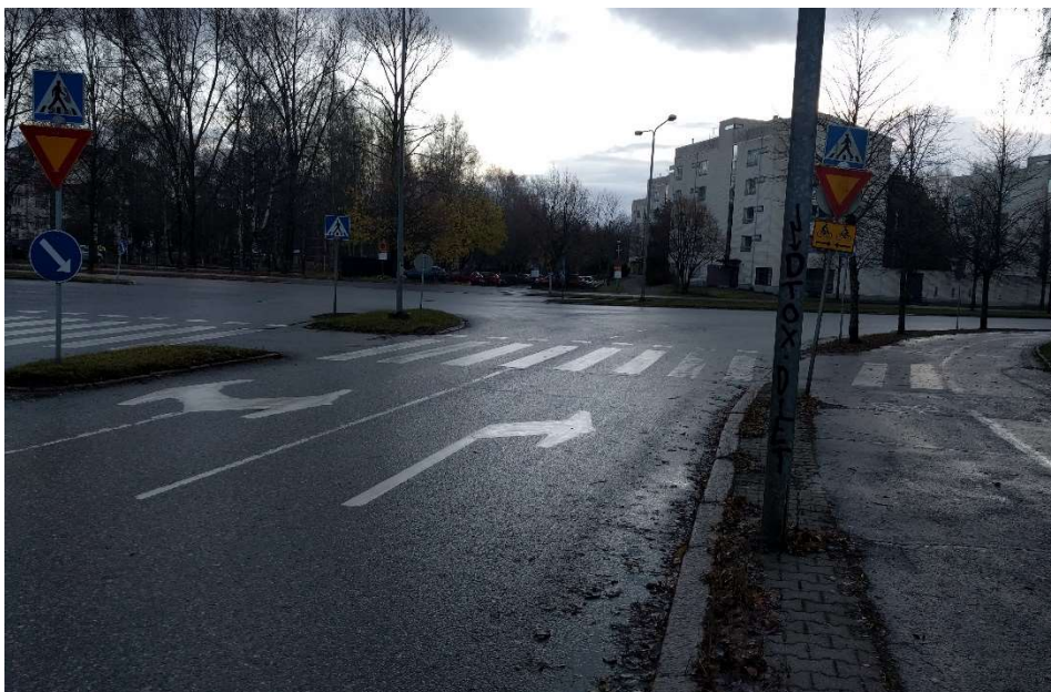
Kuva 29. Kullervonkadulla on Käpyläntielle liittyessä osoitettu kaksi kääntymiskaistaa. Suuri kaarresäde oikealle kääntymisessä mahdollistaa liittymästä läpiajamisen myös suurella nopeudella.
