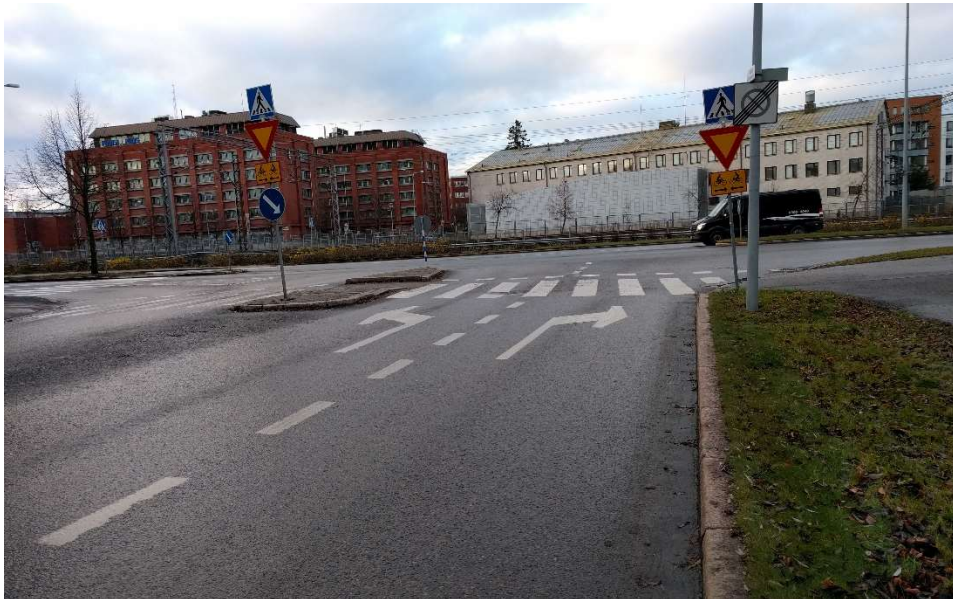
Kuva 45. Malminkaaren ja Soidintien risteys. Kuvasta katsottuna oikealla on rakennus, joka häiritsee näkemiä oikealle.
