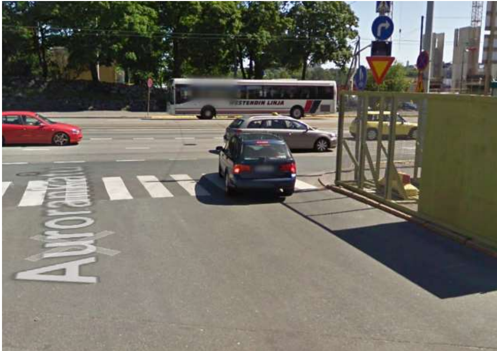
Kuva 52. Aurorankadun ja Mannerheimintien risteysalueella sijainneen työmaa-aidan luoma näkemäeste myötävaikutti viiteen pyöräliikenneonnettomuuteen vuosina 2008 – 2011. Nykyisin työmaan paikalla sijaitsee aukio. (Google Maps)
