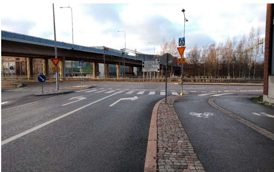
Kuva 46. Malminkaaren ja Teerisuontien risteys valmistui 2009.
