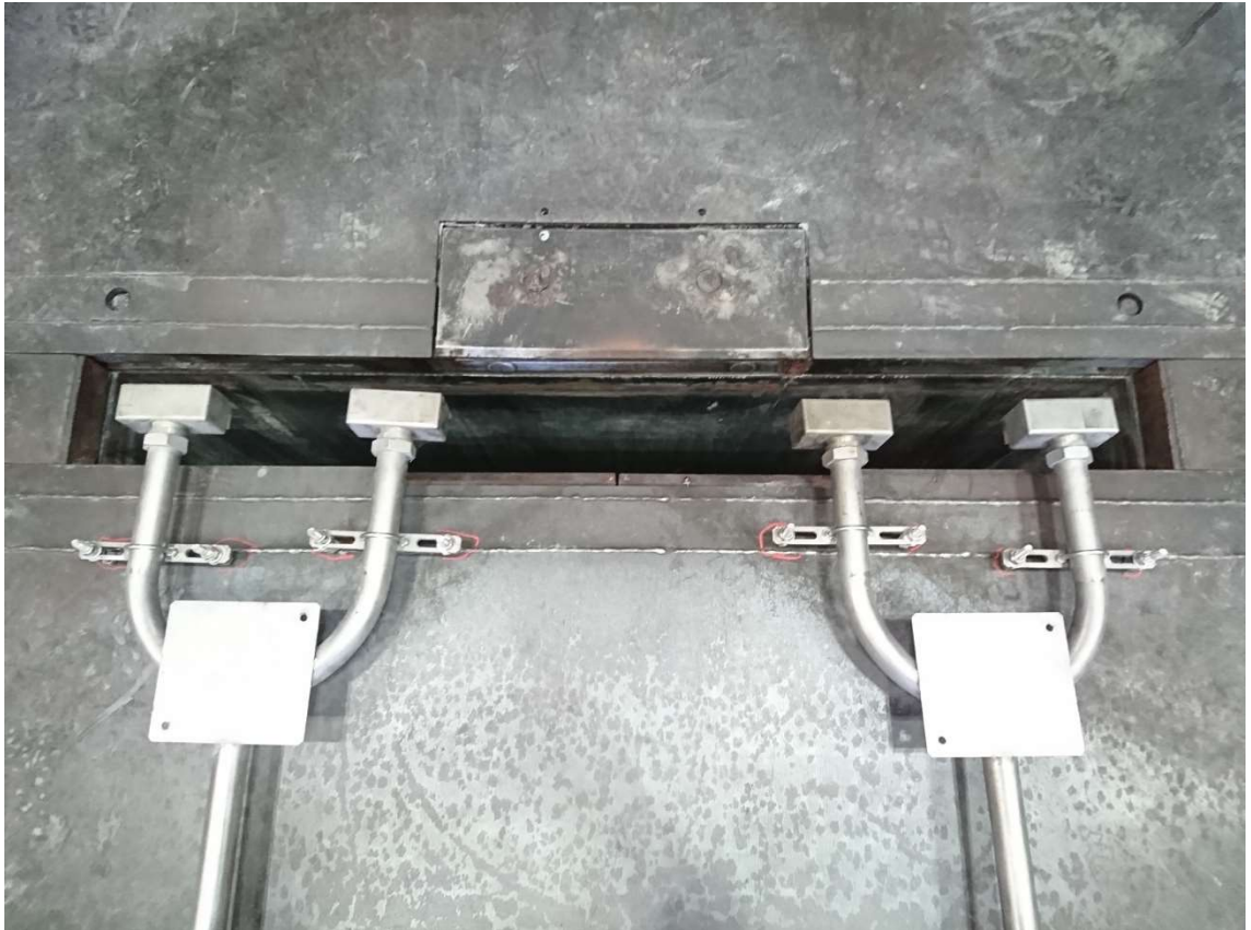
Kuva 11. Valupulveriautomaatin syöttöputket ja neljä suutinta kokillin päällä
