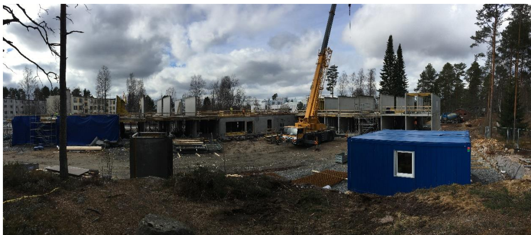
Kuva 1. Paikallavalettavan palvelukodin runko.
