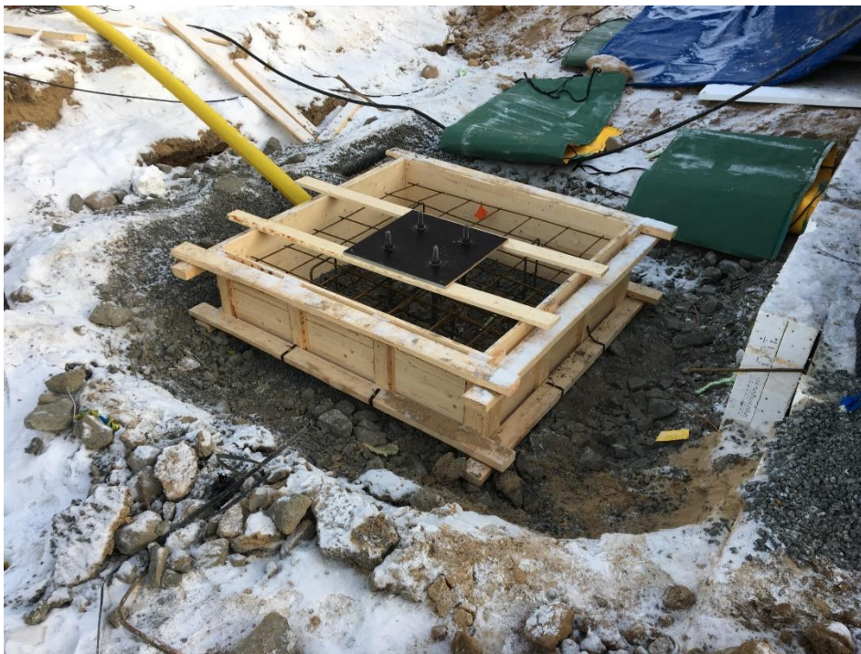
Kuva 3. Laudoitettu anturamuotti teräspilarille.
