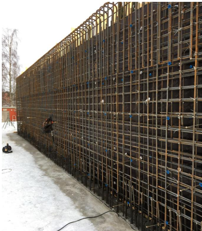
Kuva 6. Tarkastettu väestönsuojan raudoitus.
