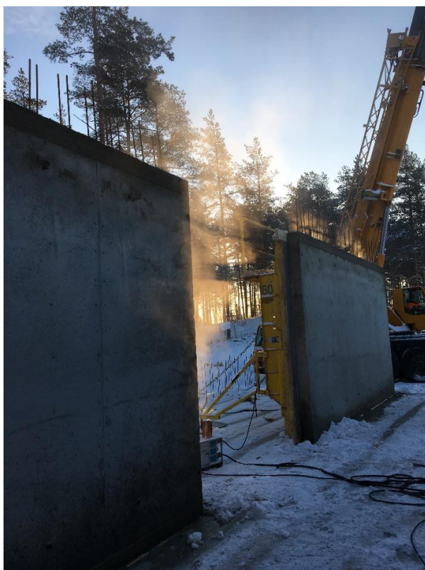
Kuva 2. Tarvittavan purkulujuuden saavuttanut paikallavalettu väliseinä talvella
