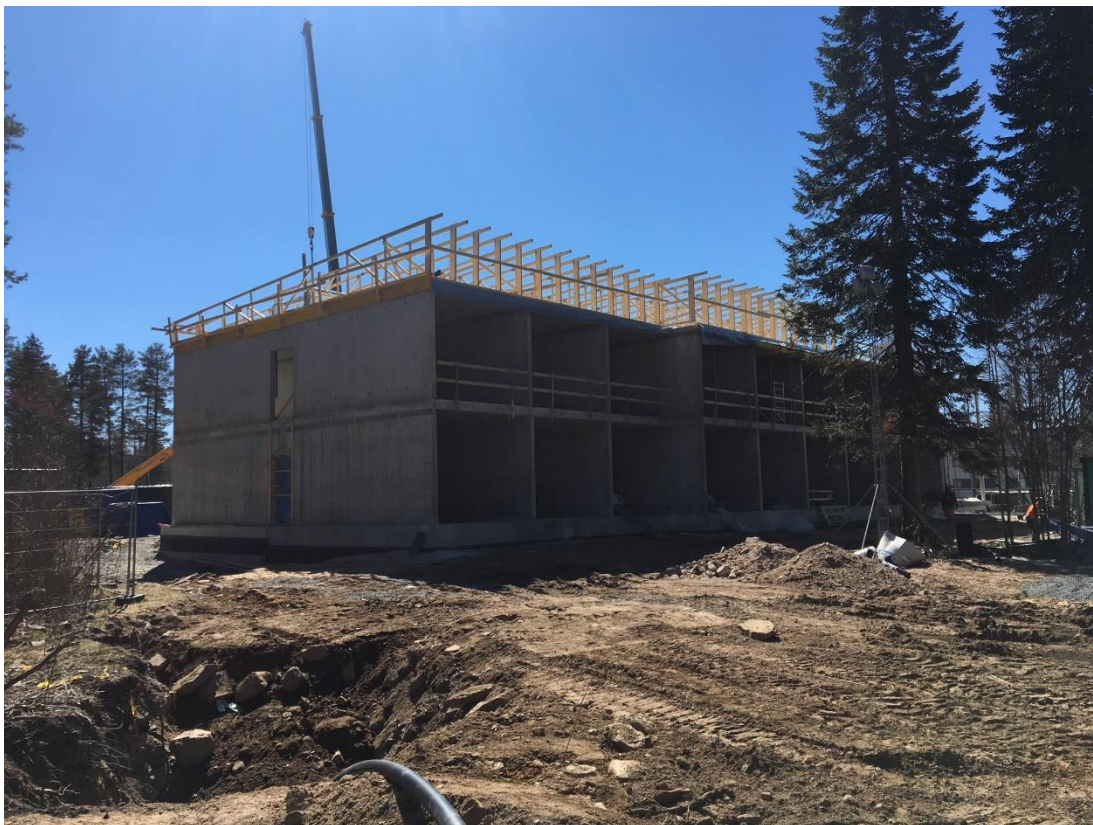
Kuva 7. Kankaanpään kantava betonirunko.
