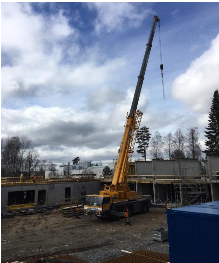
Kuva 5. Tarkastettu autonosturi Kankaanpään työmaalla.
