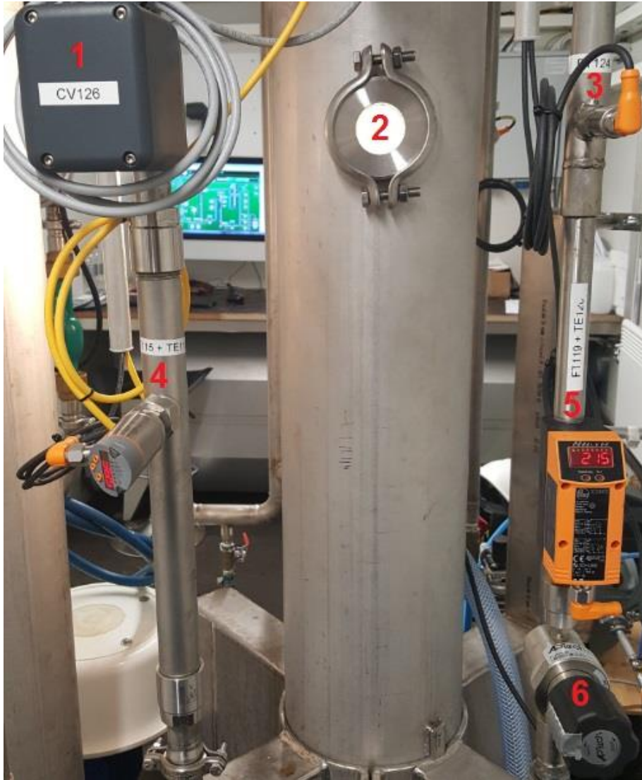
Kuva 15. Osa pilot-kontin mitta-antureista ja venttiileistä
