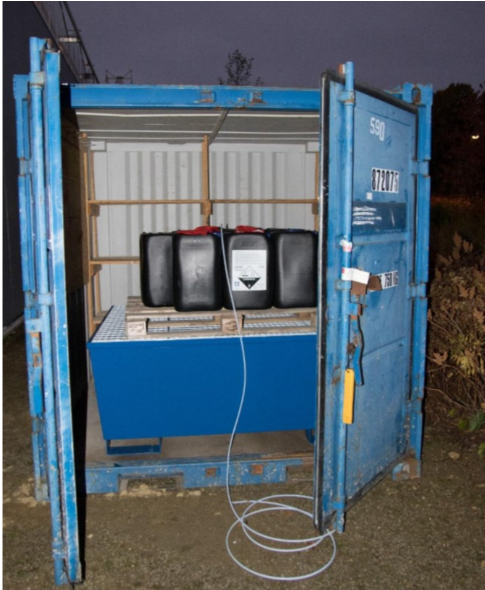
Kuva 5. Typpihappokanisterit turva-altaan päällä. (Kuva: Teo Kannainen)
