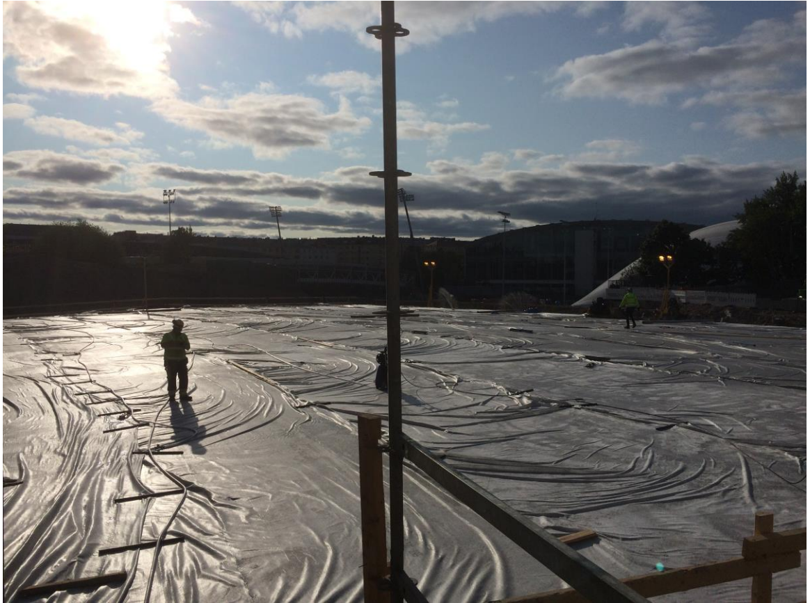
Kuva 7. Holvirakenteen jälkihoitoa kastelemalla. (24.8.2017)
