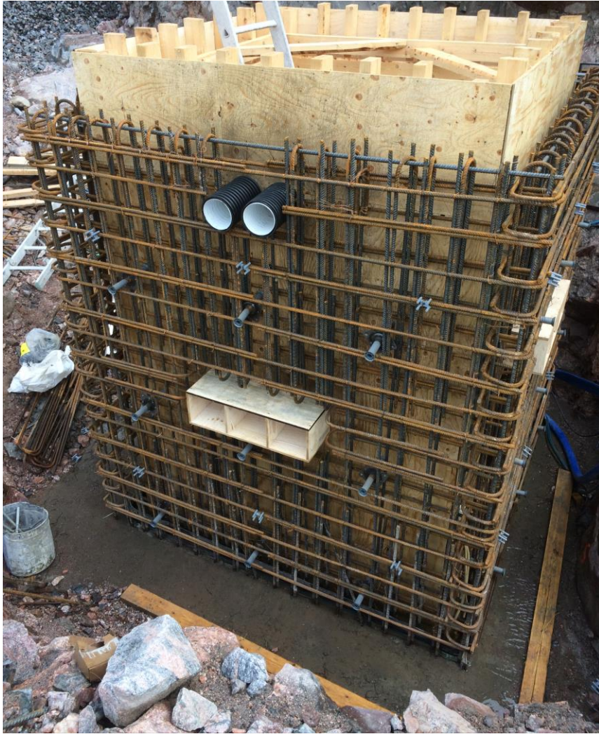
Kuva 14. Pumppaamon raudoitus, varausaukot ja välikkeet. (7.8.2017)
