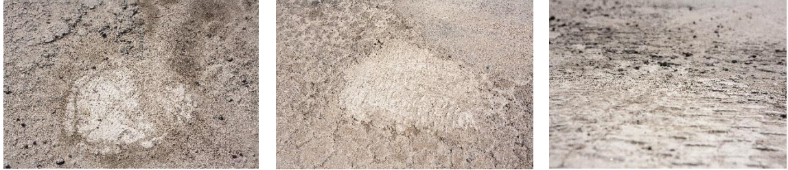
KUVA 18. PAIKKAKOHTIA VUODEN KULUTTUA PAIKKAUKSESTA.
