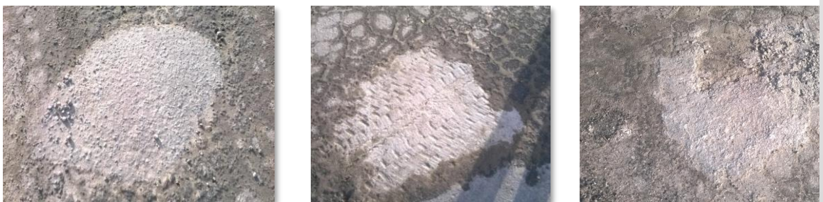
KUVA 17. KOHDE 2 KONTROLLIKUVIA 1 VUOKKO PAIKKAUKSEN JÄLKEEN.
