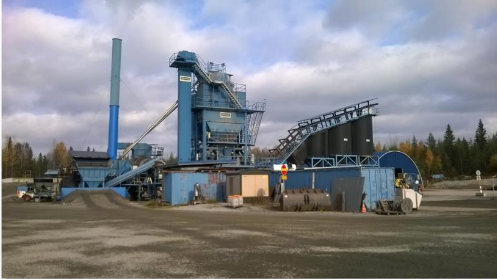
KUVA 15. KOHDE 2 VARASTOALUE JA ASFALTTIASEMA.
