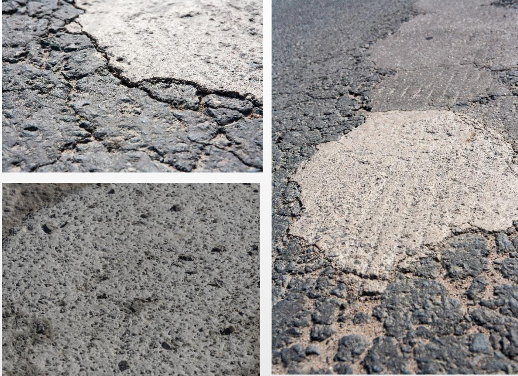
KUVA 14. KIRKKOAHONTIEN PAIKKAUKSIA VUODEN KULUTTUA PAIKKAUKSESTA.
