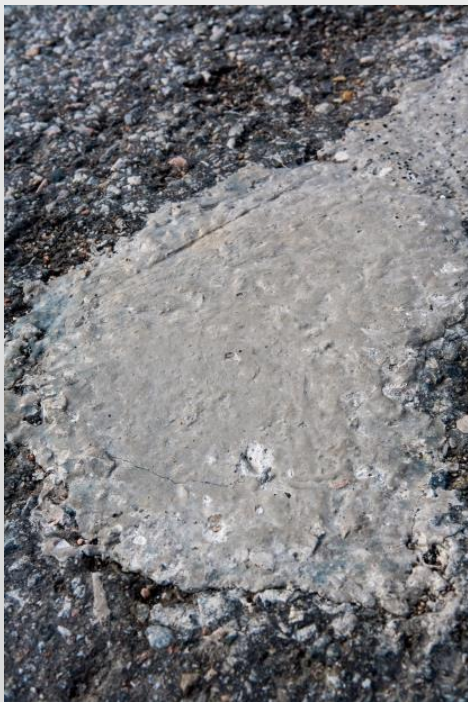
KUVA 12. KIRKKOAHONTIEN PAIKKAUKSIA VIIKON KULUTTUA PAIKKAUKSESTA.
