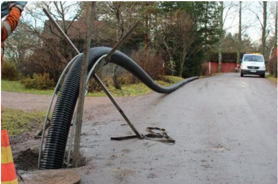
Kuva 5. Flexiputki-pitkäsujutus (Renos Oy 2017a)
