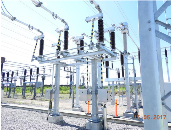
Kuvio 2. Erotin ja maadoituskytkimet (Omaisuuustiedot 2017.)
