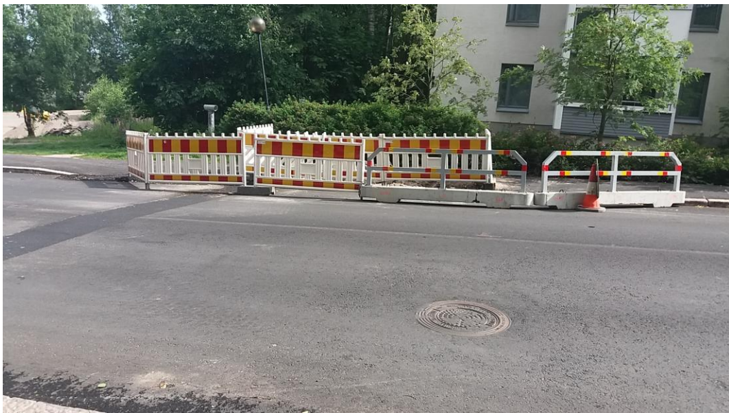
Kuva 2. Kaivannon aitaus Helsingin Herttoniemessä HSV:n työmaalla.
