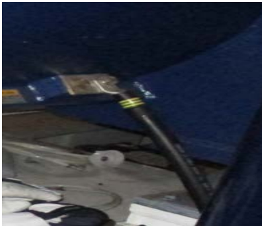
Kuva 6. Generaattorin maadoitus tehty pyöreällä 16mm 2 kaapelilla.
