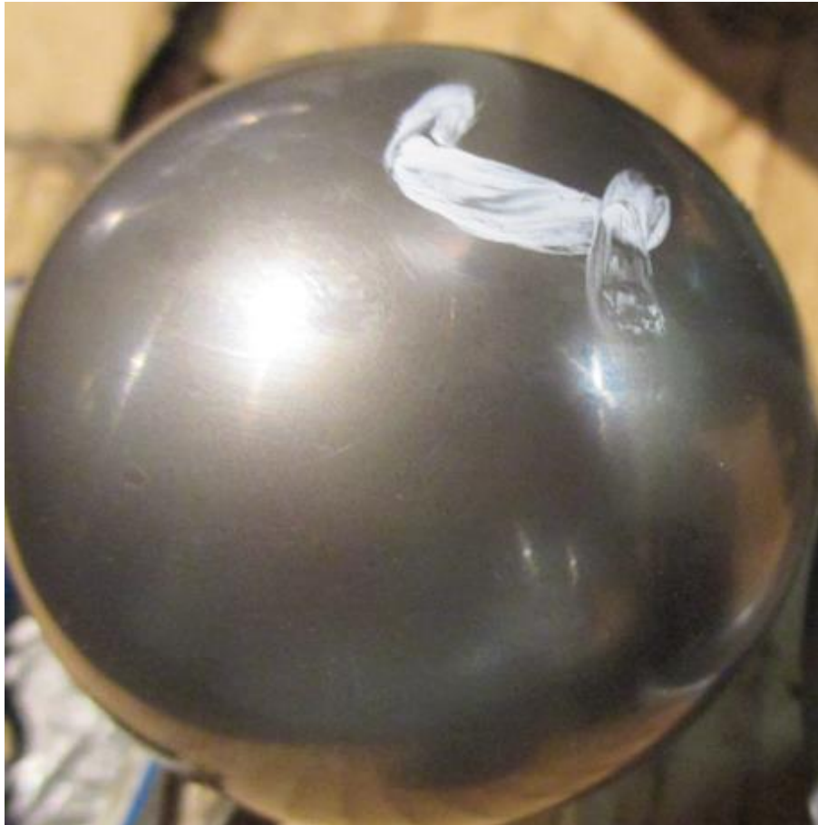
Kuva 32. Myös kuulat harmaantuneet, mikä on varsin tyypillistä sähkönkulun aiheuttamaa vauriota.
