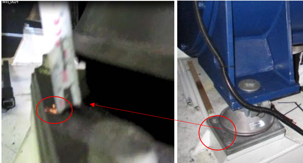
Kuva 39. Kipinöintiä rullamitan ja pedin välillä. Generaattori on asennettu vaimenninkumien päälle, jolla on saadaan galvaaninen erotus pedistä. Kun rullamitta kytketty vaimenninkumin yli, syntyy kipinöintiä varsin paljon.
