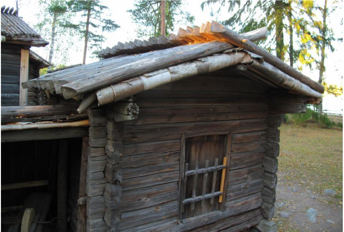
Kuva 6. Malkakatto, jossa malat on kiinnitetty toisiinsa harjatapilla.
