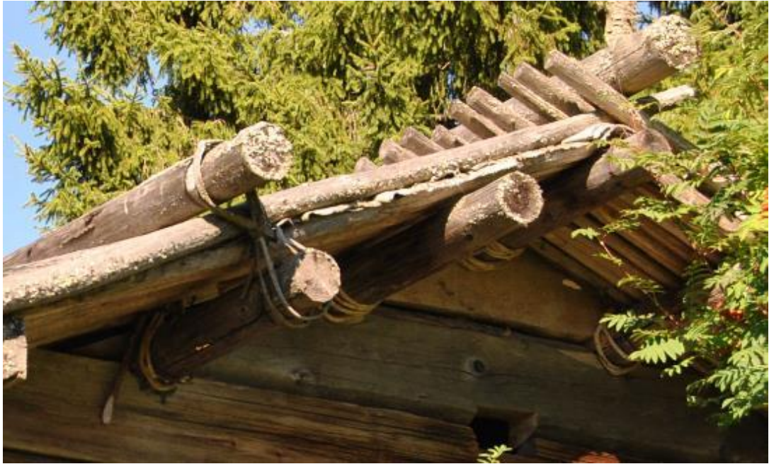
Kuva 15. Kuvan katossa sekä painopuut että räystäskoukut on sidottu vuoliaisiin vitsaksilla.
