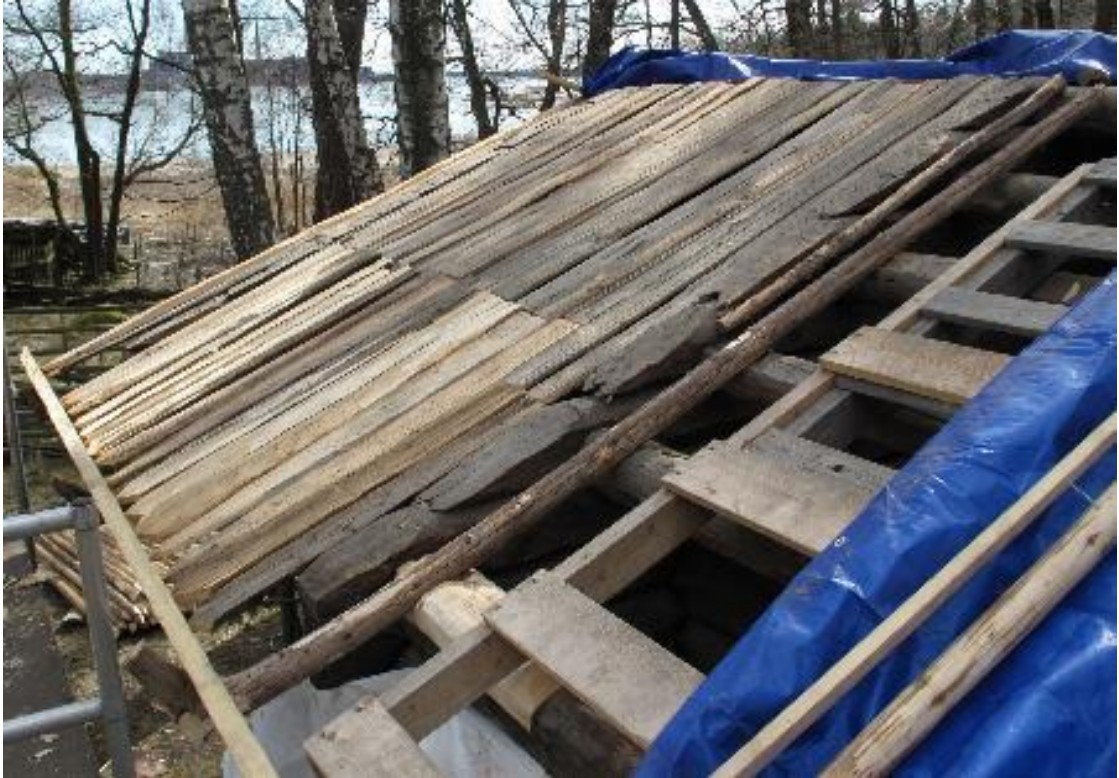
Kuva 4. Räystäslankullinen kattorakenne, jonka restauroinnissa on uusittu alusliisteitä, räystäskoukkuja ja räystäslankku.
