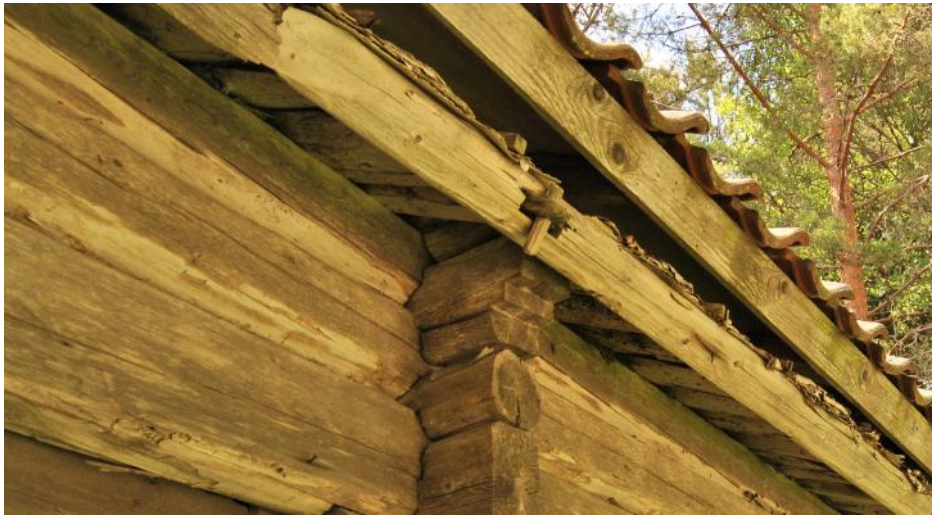
Kuva 9. Tässä nykyään tiilikatolla suojatussa rakennuksessa on säilynyt malkakatteen aluskerrokset miekkapuineen.
