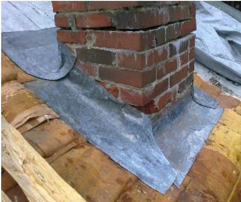
Kuva 25. Savupiipun juuri on suojattu neljästä lyijypellin palasta tehdyllä kauluksella.
