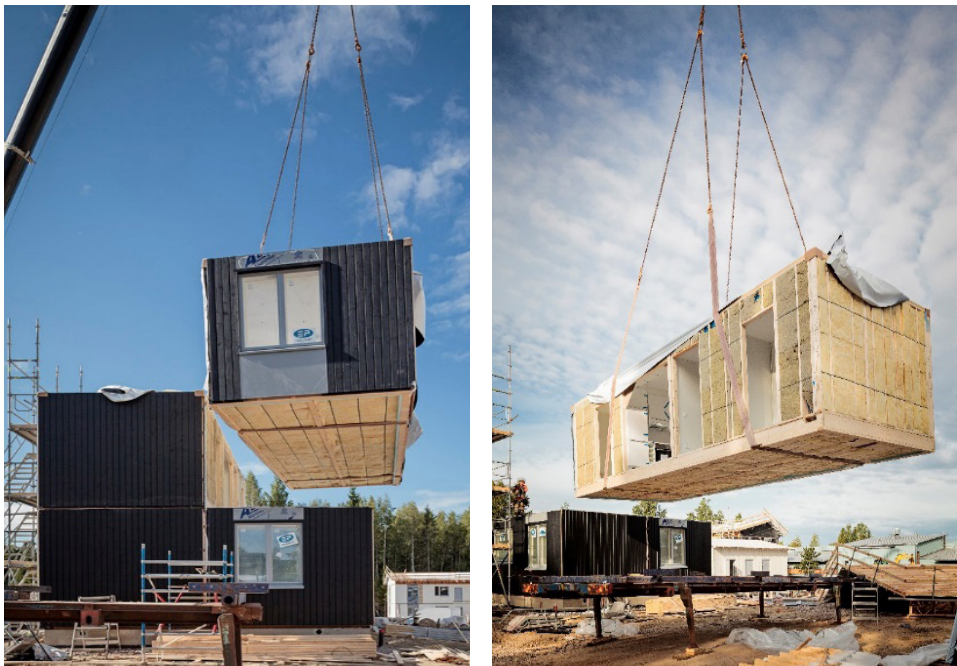
Kuva 4. Vasemmassa kuvassa tilaelementti ilman julkisivuverhousta ja oikeassa kuvassa tilaelementti, jossa myös julkisivuverhouk. [4]
