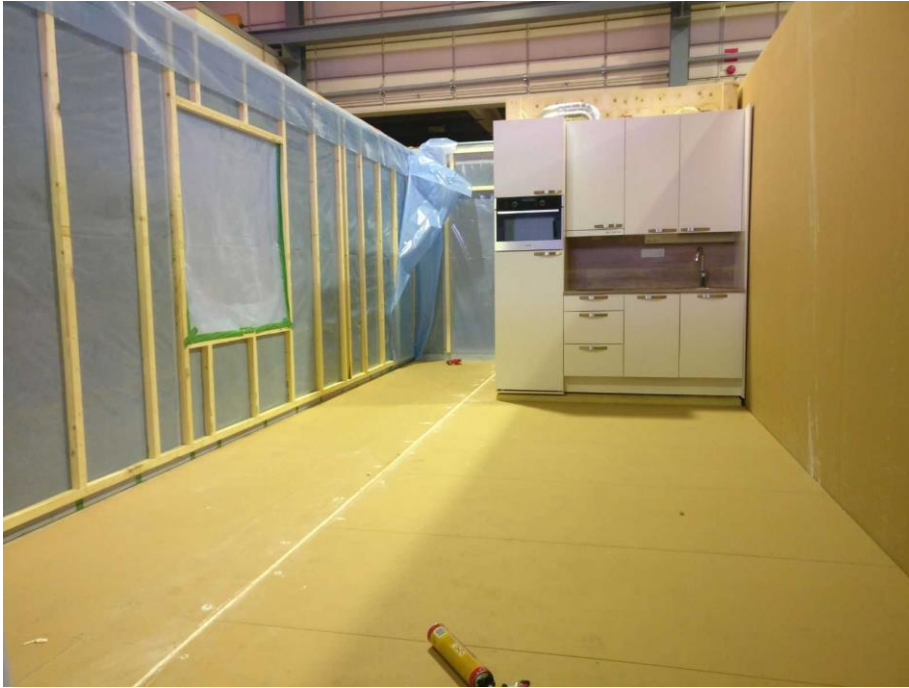
KUVA 3. Kylpyhuonemuoduli asennettuna tilaelementtiin (Vikki 2018)
