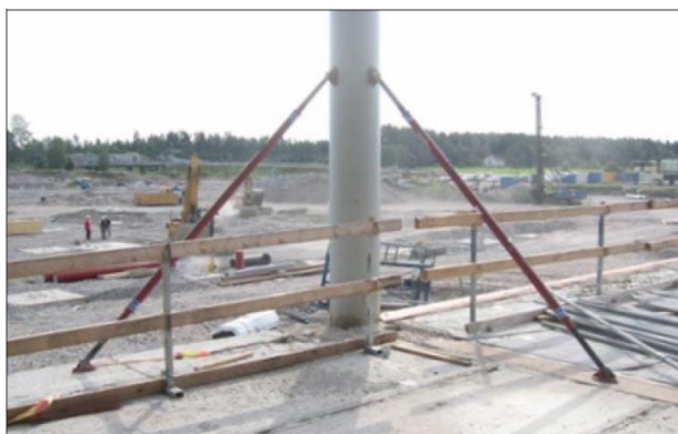
Kuvio 42. Liittopilarin asennusaikainen tuenta /24/.
