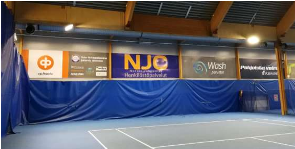
KUVA 14. Tennis- ja sulkapallokenttien ilmanjako
