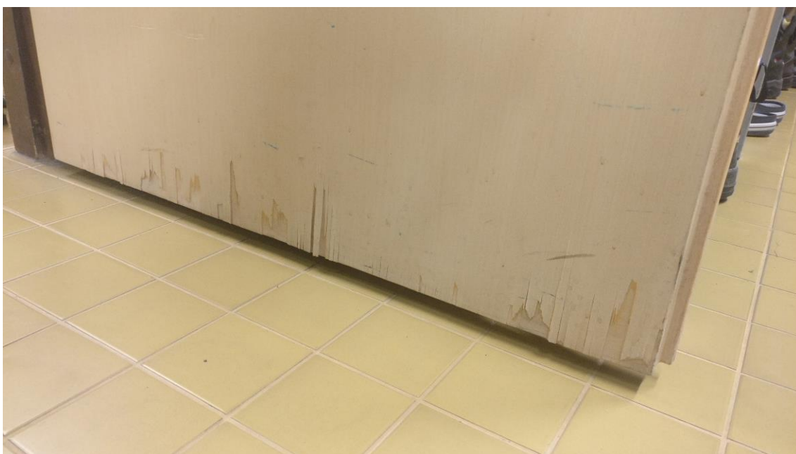
Kuva 16, kuivaus- ja pukuhuoneen väliovi.
