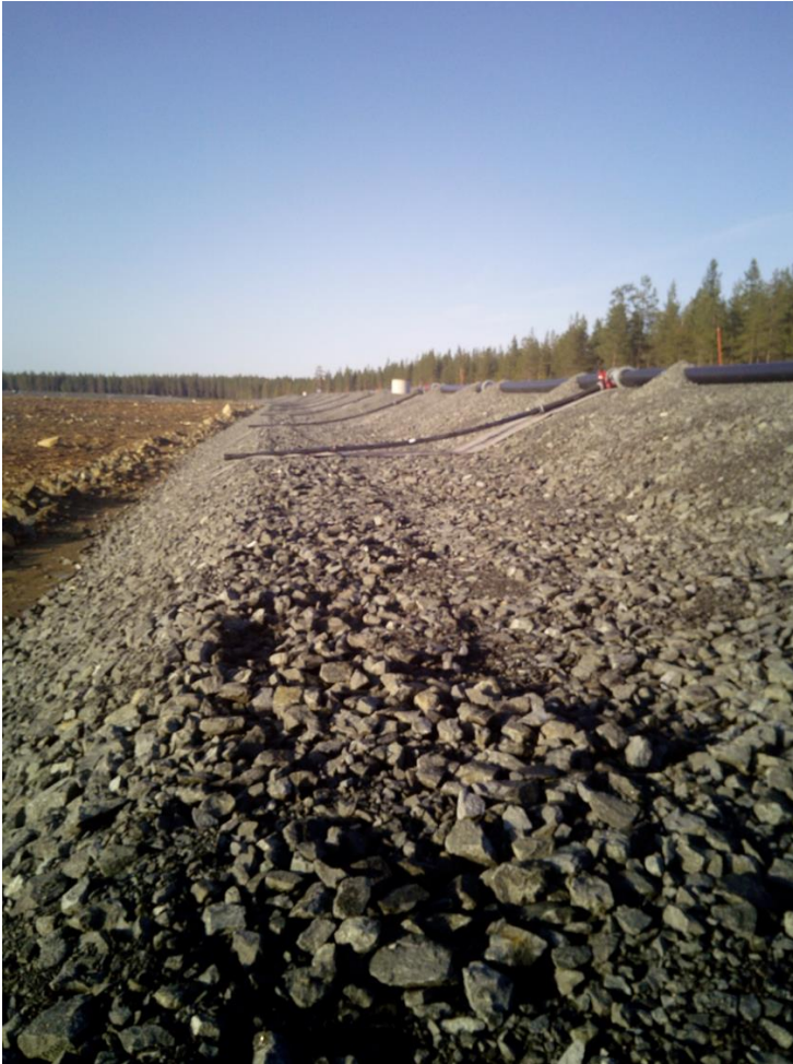
KUVA 18. Valmis eroosiosuojaus (myös järjestelmäsiirrot on tehty)
