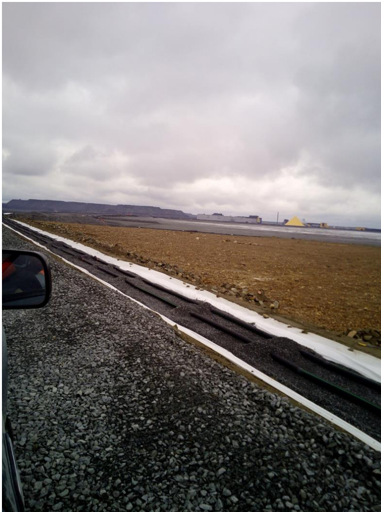
KUVA 16. Juurisalaojaputket asennettuna
