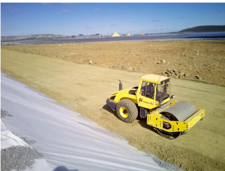
KUVA 15. Moreenitiivisten tiivistämistä 15 tonnissella valssijyrällä
