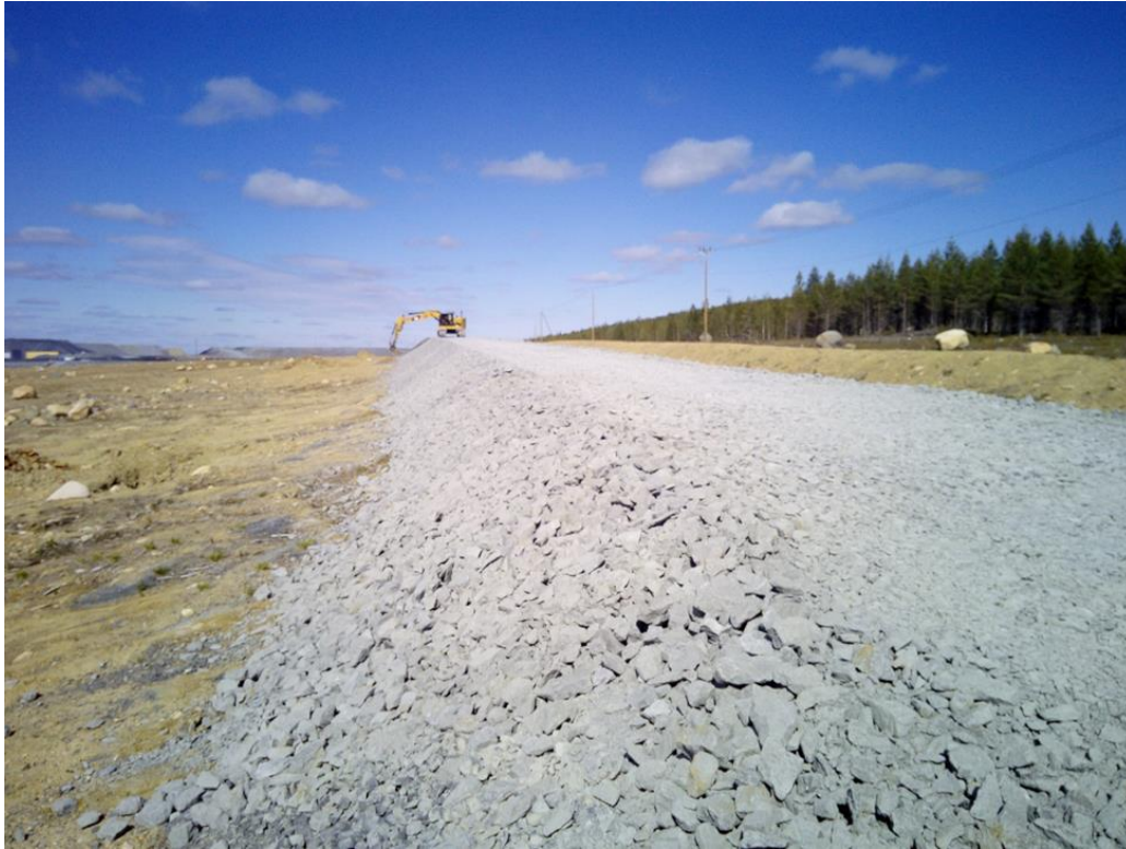
KUVA 9. Valmis louhetukipenger ML 2
