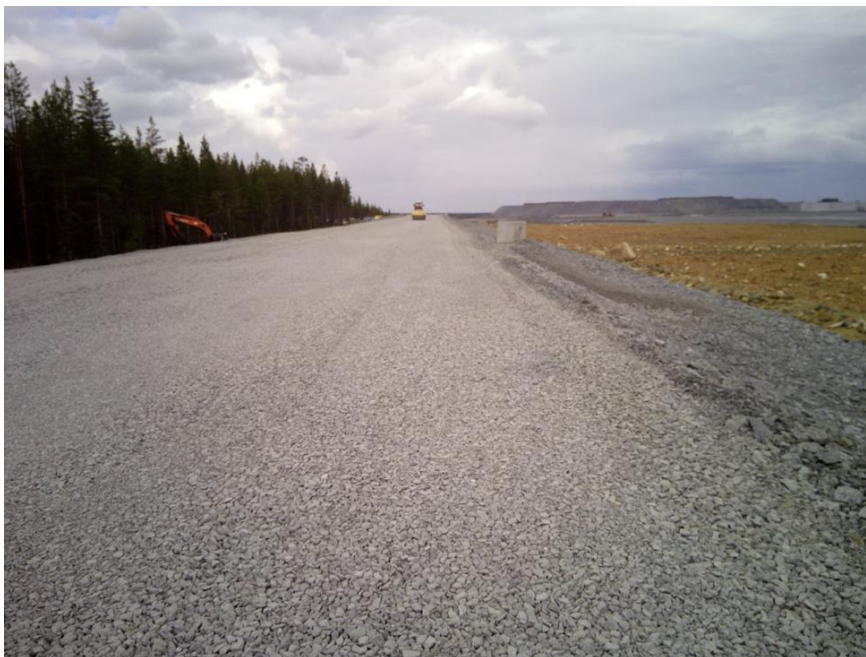
KUVA 17. Valmis kantava kerros
