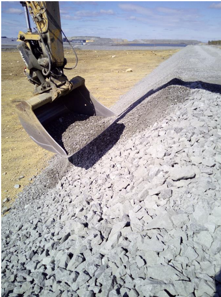
KUVA 10. Vinosuodattimen rakennus kalliomurskeella
