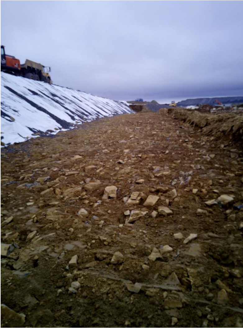
KUVA 12. Tiivisteura. Kuvassa näkyy myös vinosuodattimeen asennettu suodatinkangas.
