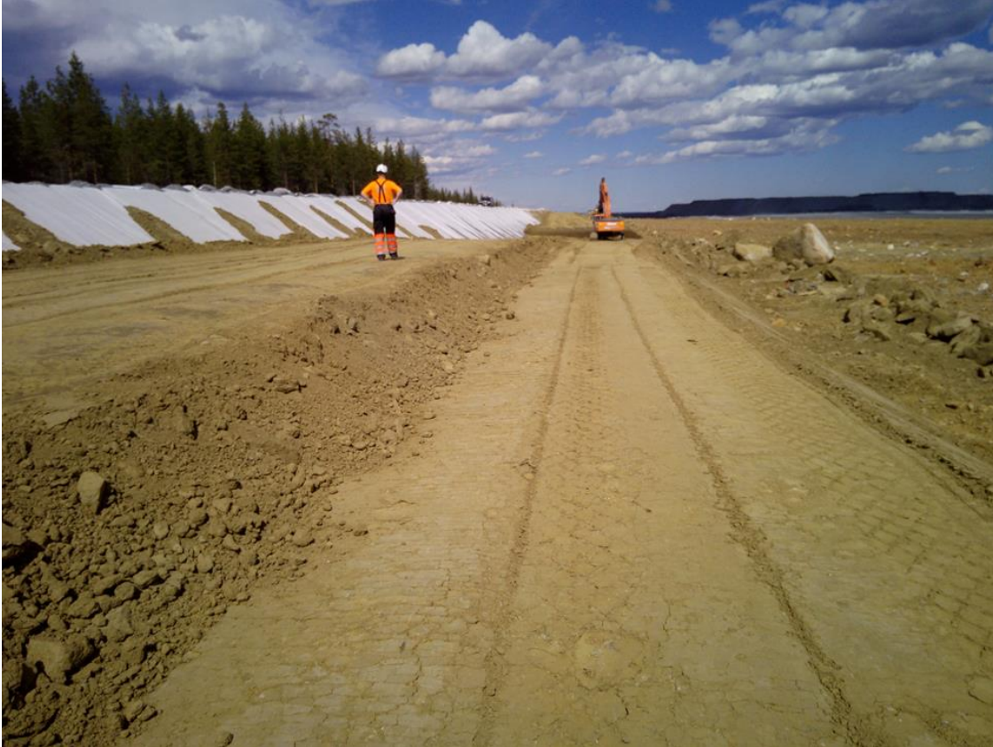
KUVA 13. Moreenitiivisteiden rakentamista (alemmalle tasolle asennetaan juurisalaojaputket)
