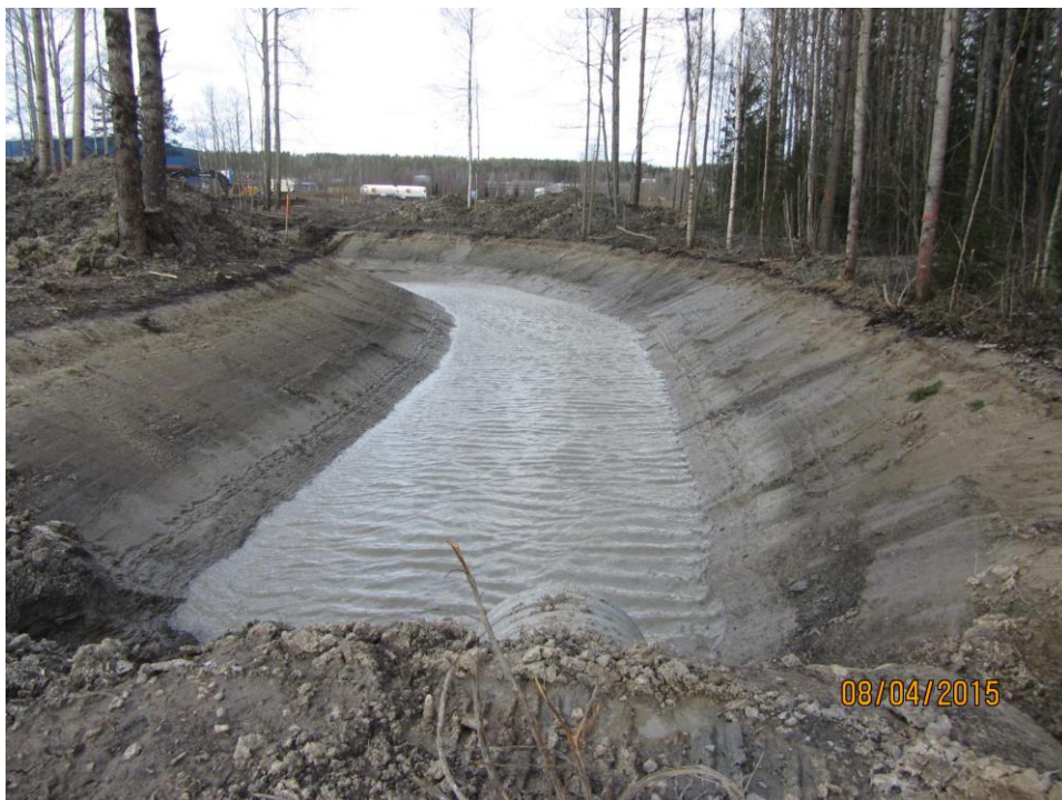
Kuva 8. Tasausaltaan rakentaminen Teholan alueella (Kimmo 2017c).
