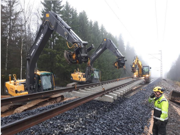
KUVA 6. Elementin siirto. Kuvaaja: Veli-Matti Laasonen 2017.
