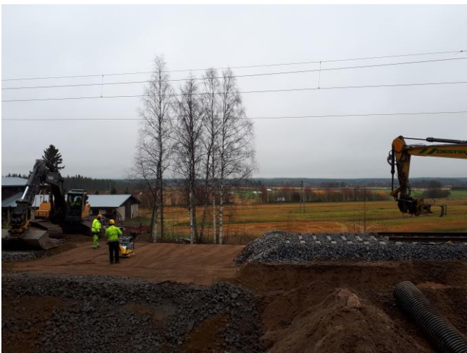
KUVA 7. Tiivistys. Kuvaaja: Veli-Matti Laasonen 2017
