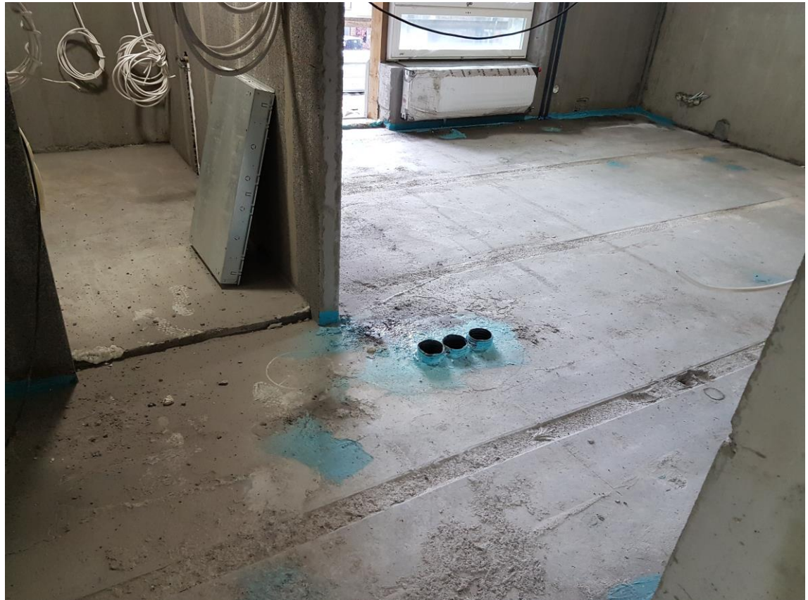
Kuva 3. Etuputsi ja plaanovalmistelut käynnissä.
