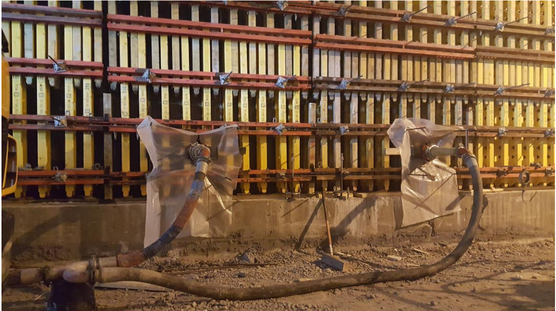
Kuva 15. Seinävalu kahdella valumansetilla, GRK, Pasila, Teollisuuskatu
