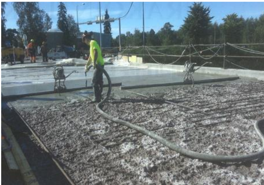
Kuva 11. Itsetiivistyvän betonin levitystä Tapiolan risteysillalla [9, s. 19.]
