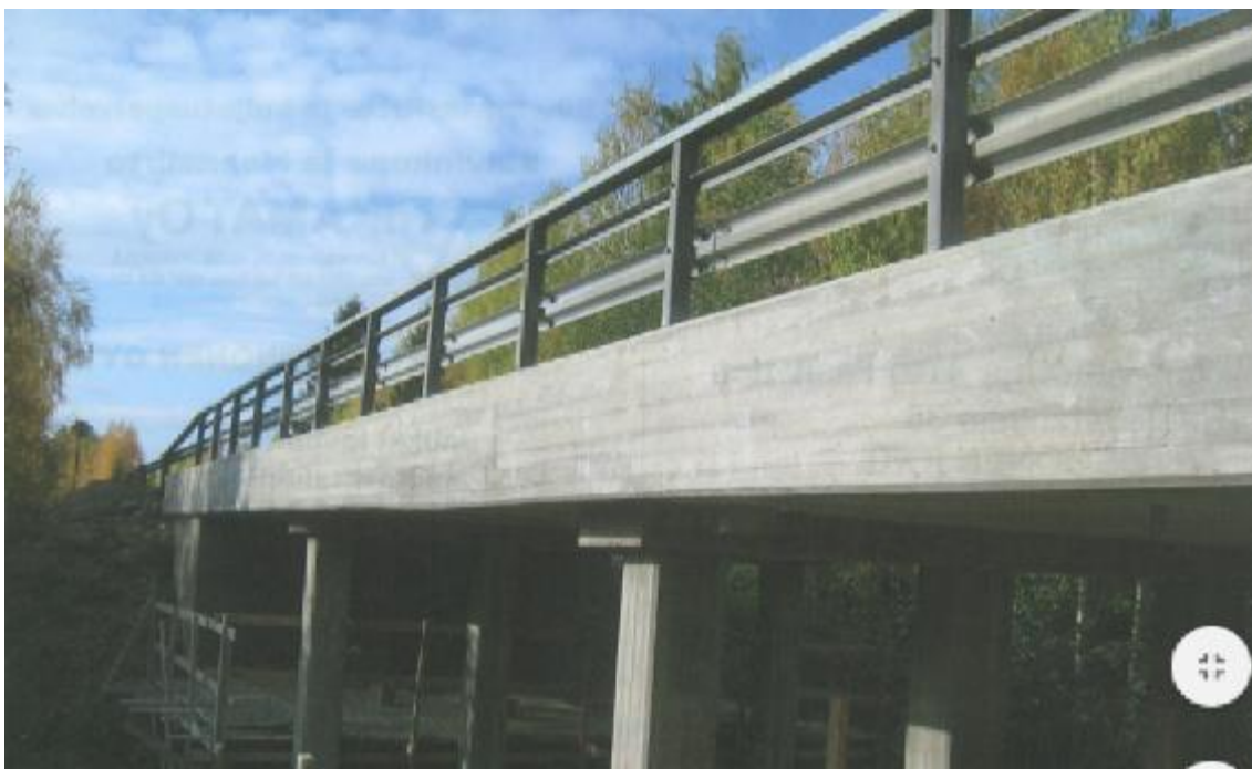
Kuva 9. Kuorivalulla korjattu sillan reunapalkki [9, s. 20.]
