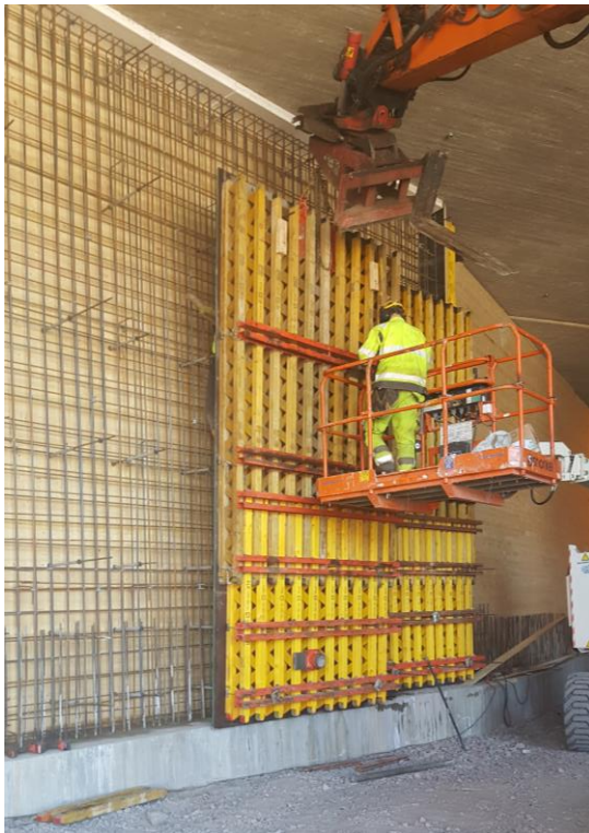
Kuva 13. Seinämuotin asentaminen käynnissä
