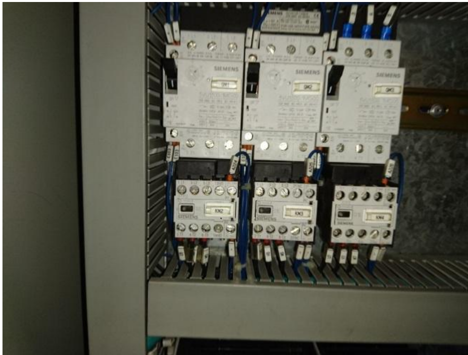
Kuva 11. Jokaiselle kuljettimille on oma etukoje ja vanhoja kytkentöjä ei muutettu. Kuljettimilta saatiin yksi yhteinen ylikuumentumishälytys. Moottorilähtö koostuu moottorisuojakytkimestä ja kontaktorista.
