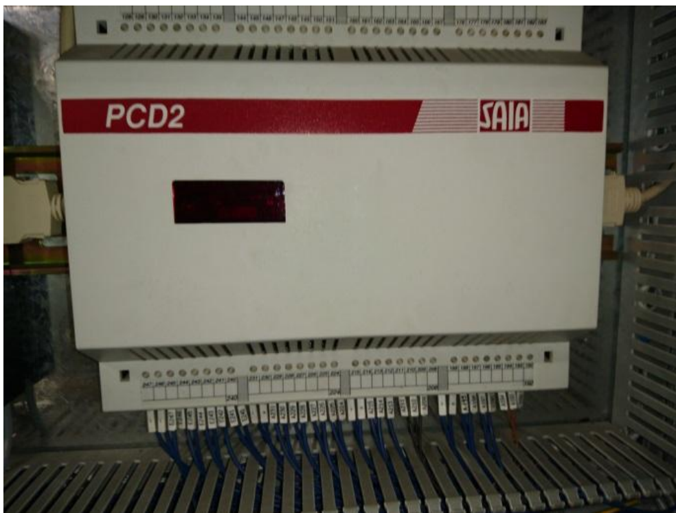
Kuva 7. Robotin ohjaus ennen moderisointia oli toteutettu kahdella kuvan kaltaisella logiikalla. Nämä logiikat korvattiin kahdella IFM:n modulilla.
