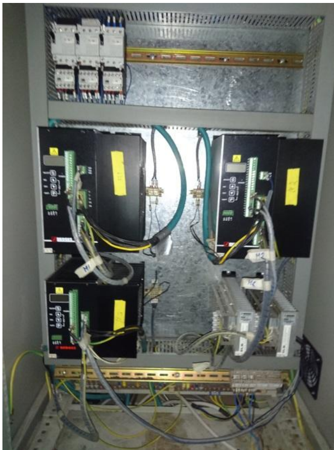
Kuva 12. Robotin akseleiden moottorien servo-ohjaimet, joiden avulla saadaan ohjattua akseleiden liikenopeutta.
