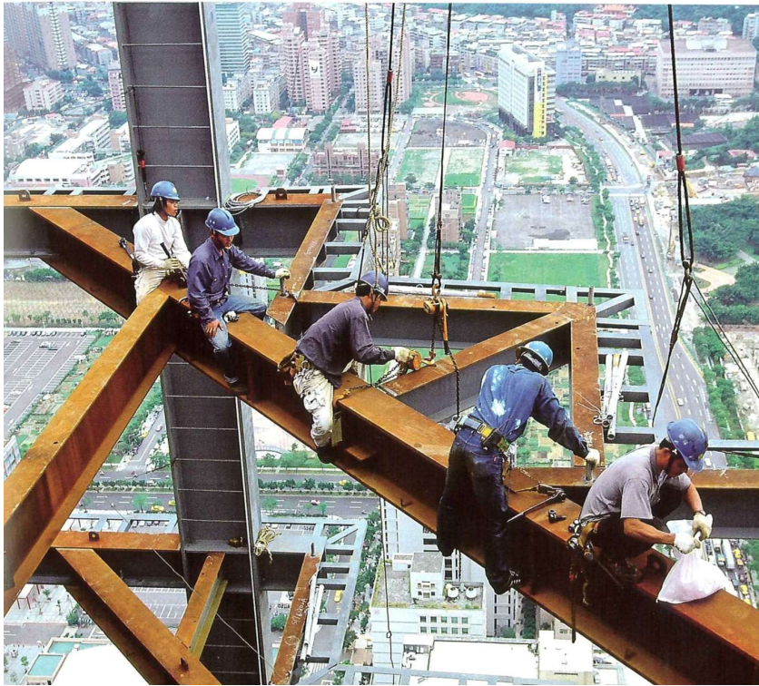
Kuva 2. Taiwanissa sijaitsevan Taipei 101 rakentaminen käynnissä (Meriläinen 2018)
