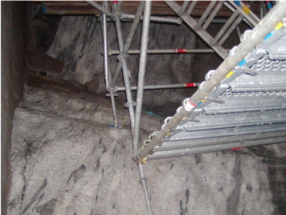
Kuva 5.1 Telineiden tukijalan tuenta vinolle pinnalle siilon pohjalla (Nordkalk oyj)
