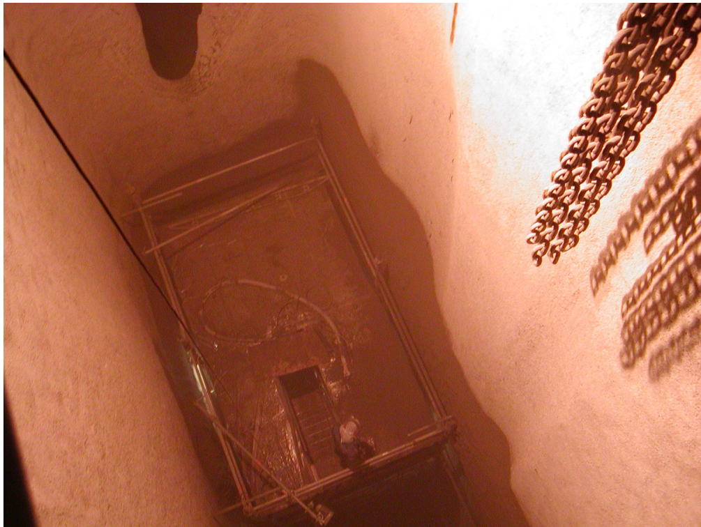
Kuva 5.2 Telineiden päälle tehty taso turvallisuuden parantamiseksi (Nordkalk oy)
