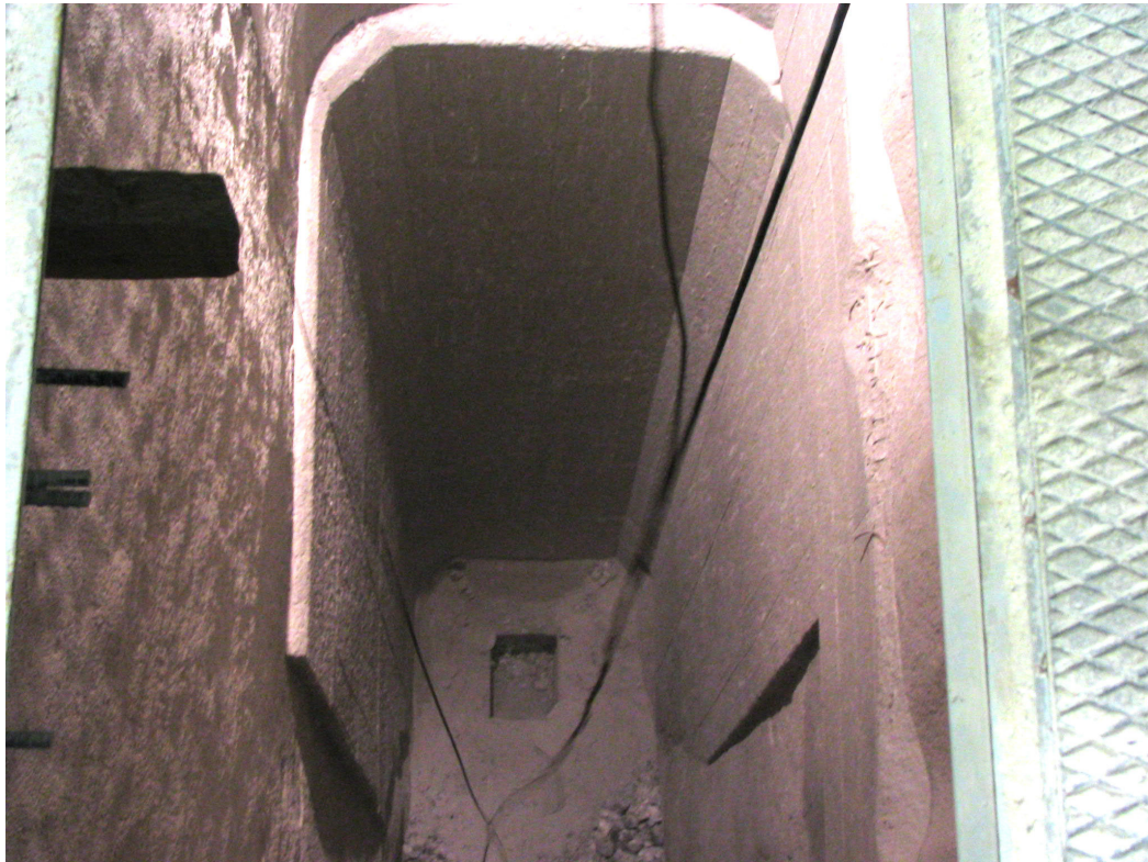
Kuva 4.1 5-siiloa vahvistettu tasolle +63.00 (Nordkalk oyj)
