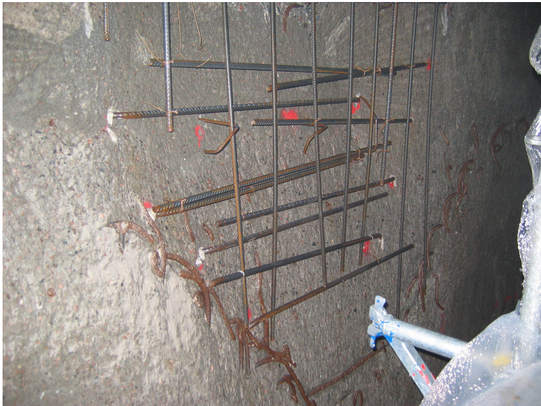
Kuva 2.5 Kuluneen seinän raudoitusta uusittu ennen korjausta. (Suomen Rakennelujitus Oy)
