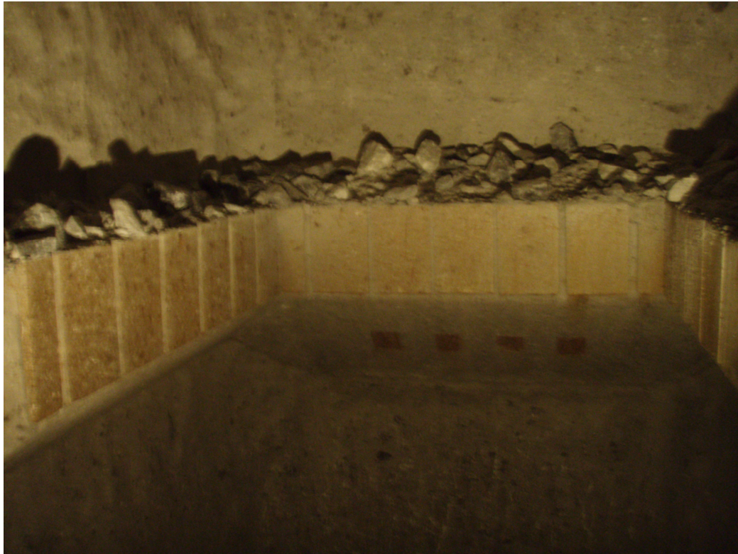
Kuva 2.4. Metallilevyillä päällystetty kivihylly. (Nordkalk oyj)
