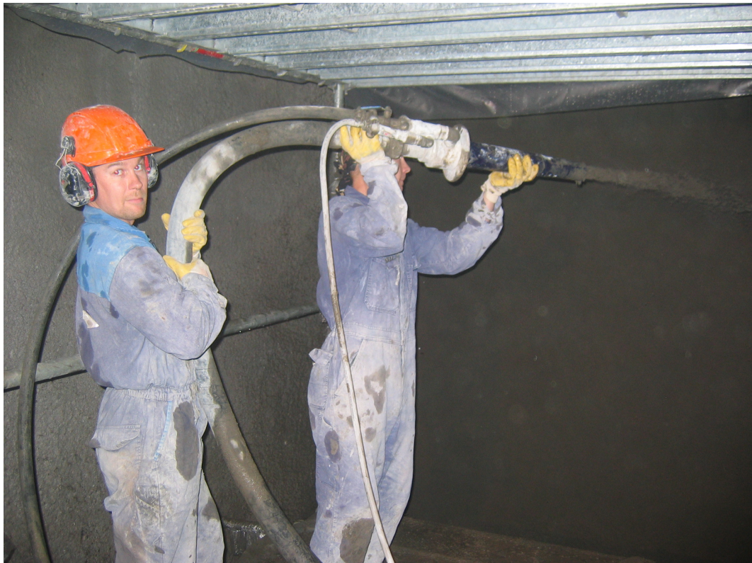
Kuva 3.1 Ruiskutusta telineiltä (Suomen Rakennelujitus Oy)
