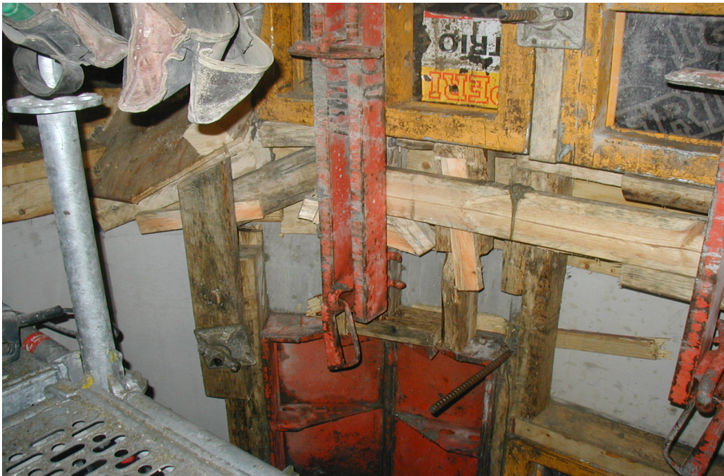
Kuva 4.3 Muotin alapään tiiviiksi laudoittamista (Suomen Rakennelujitus Oy)
