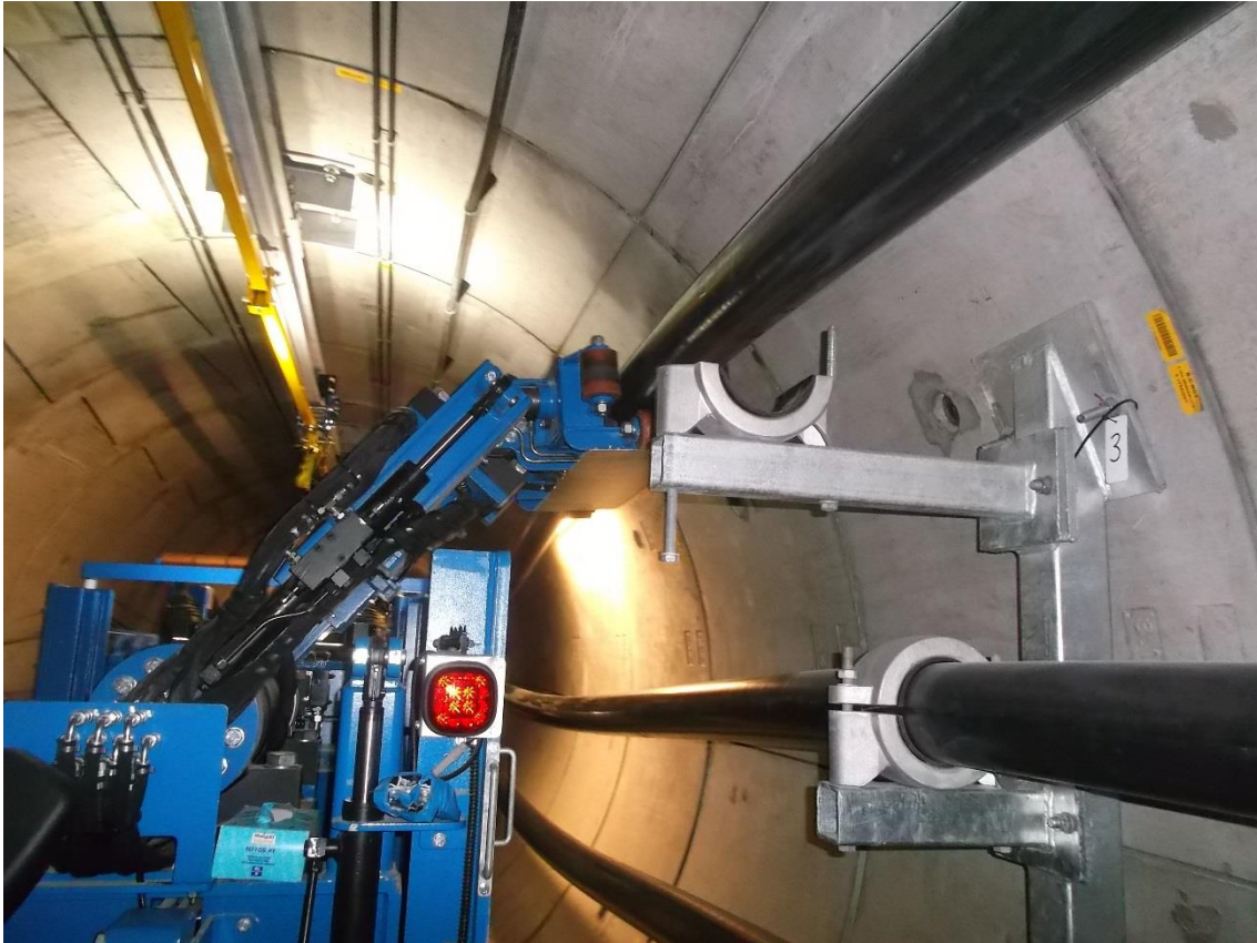
KUVA 17. Suurjännitekaapelia asennetaan tunneliin Lontoossa (National Grid 2018).
