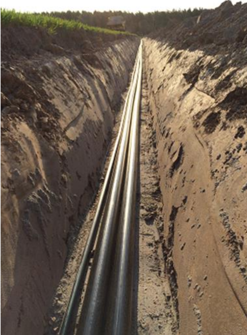
KUVA 18. Kaapeliojaan asennettua maakaapelia (NCC 2018b).
