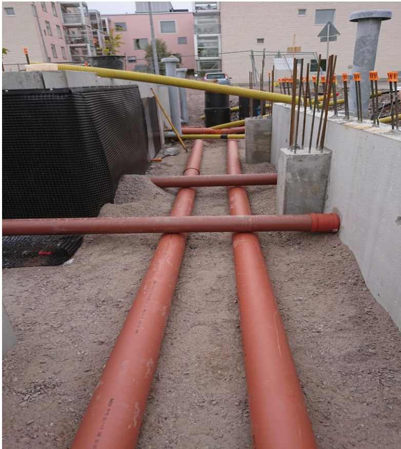
Kuva 6 Talotekniikan reititykset
