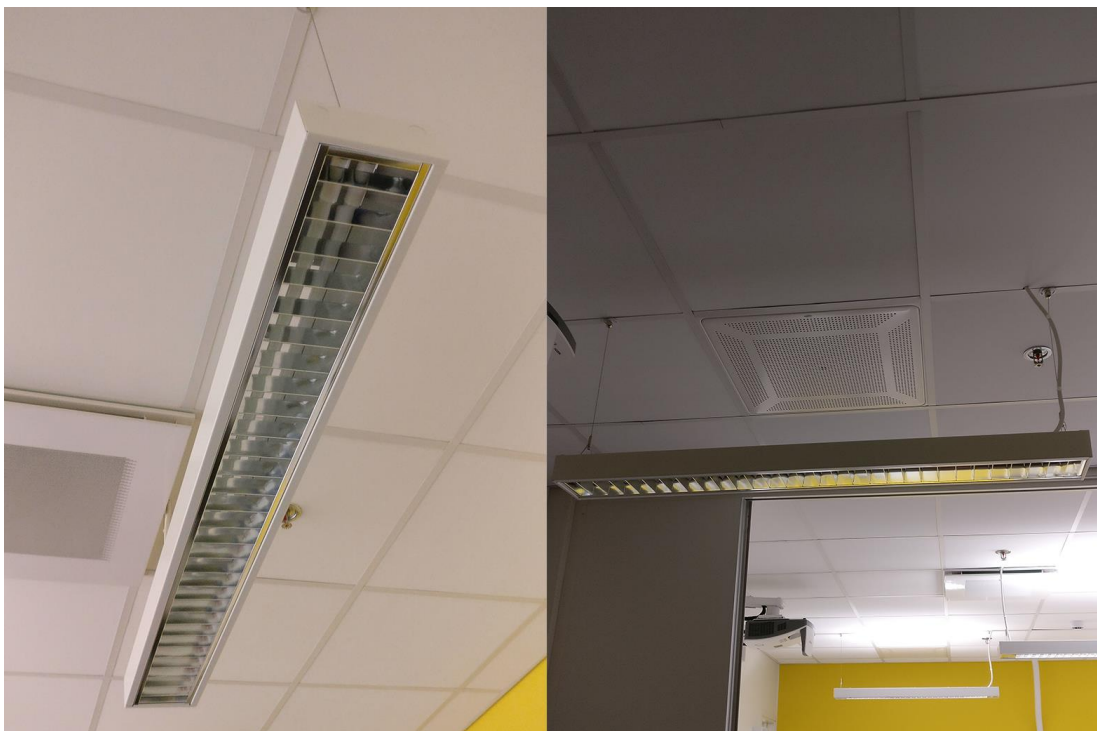
Kuva 10. Valaisimen sijainti ja rakenne (Vaali 2018).
