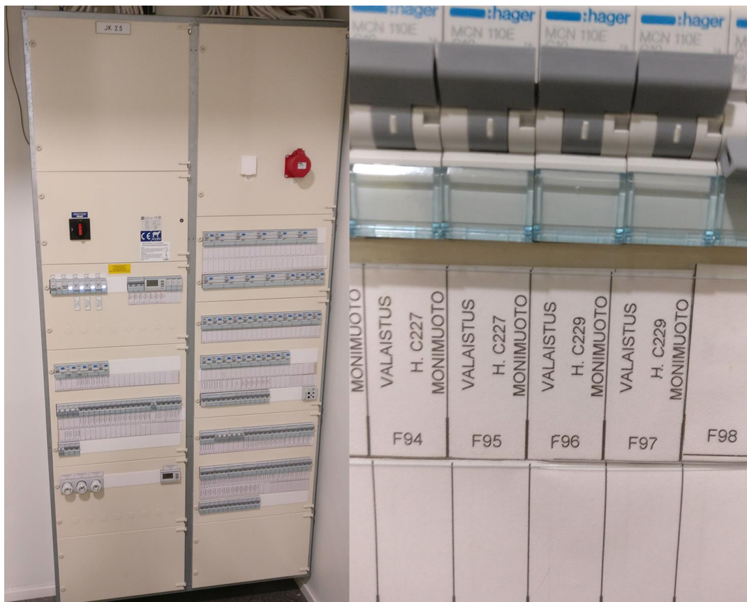
Kuva 13. Sähkökeskus ja luokkahuoneiden valaistuksesta vastaavat kytkimet (Vaali 2018).
