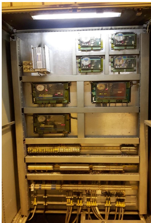
Kuva 7. SK6 ovi auki.
