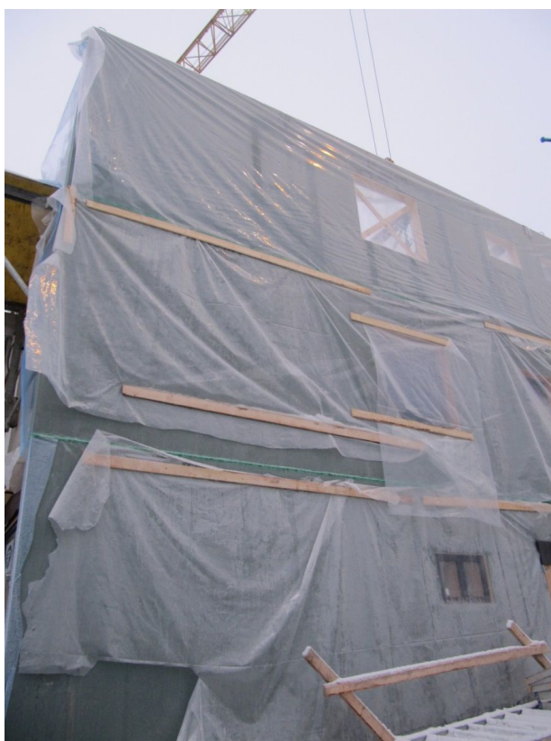
Kuva 8. Puurunkoisten elementtien asennus ja suojaus (Leskinen Arto 2018)
