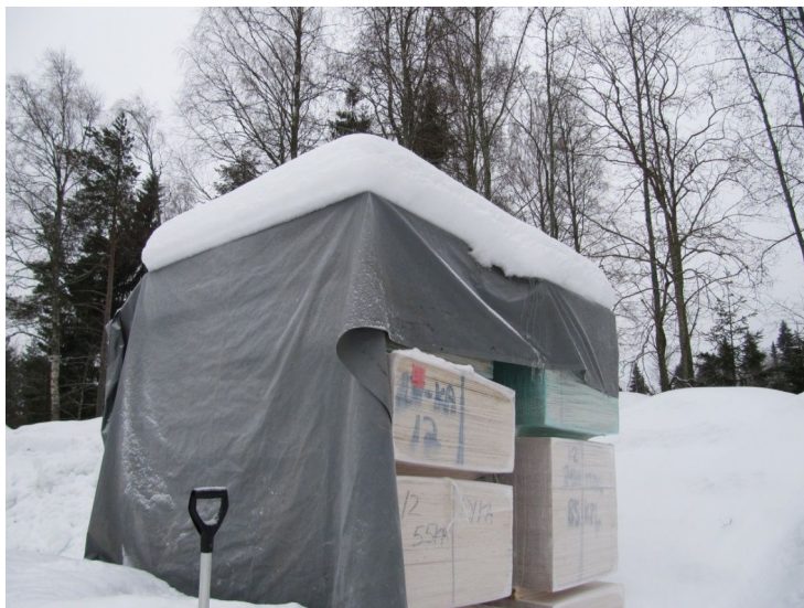
Kuva 7. Rakennustarvikkeiden suojaus kestopitteellä (Leskinen Arto 2018)
