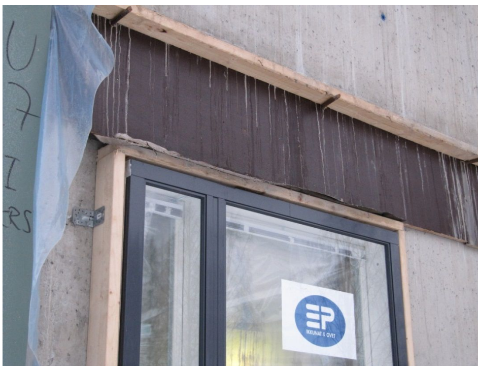
Kuva 10. Ikkunan apukarmin yläpinta suojattu huopakermikaistalla. (Leskinen Arto 2018)
