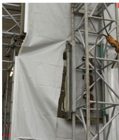
Figur 10: Detalj på klättrande väderskydd. 55
