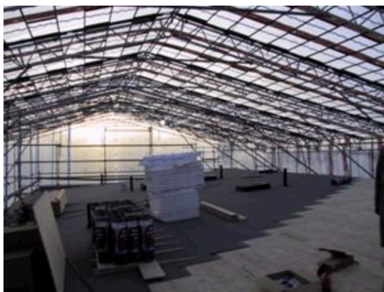
Figur 8: En bild på fast takväderskydd. 51
