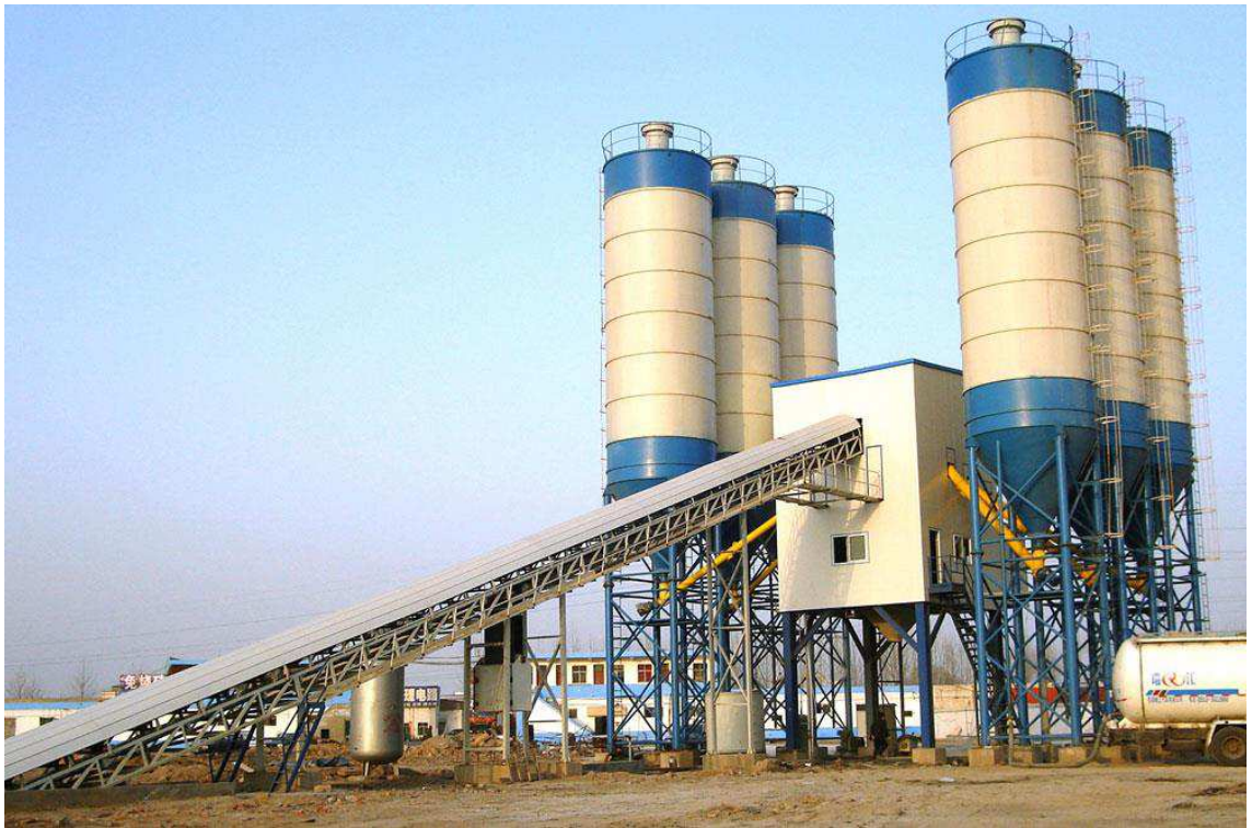
Kuva 3. Kiinteä betoniasema. (Wikimedia)
