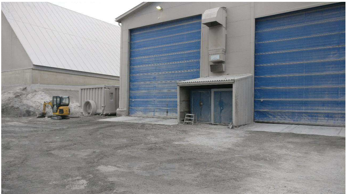
Kuva 1. Valokuva lähtötilanteesta huoltohallien edustalla.
