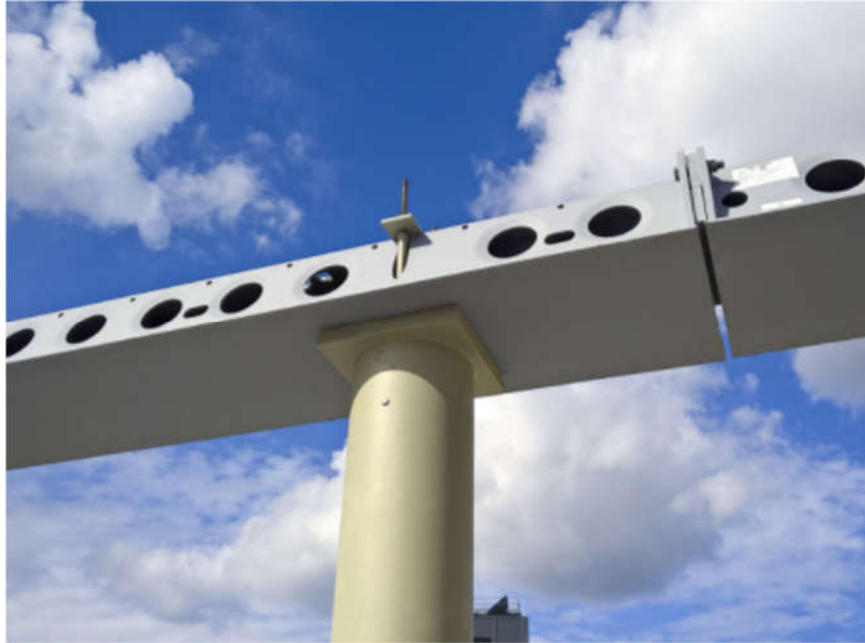
Kuva 6. Pulttiliitos pilarin päällä [26].
