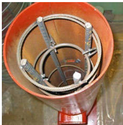
Kuva 7. Raudoitus liittopilarin sisällä [27].
