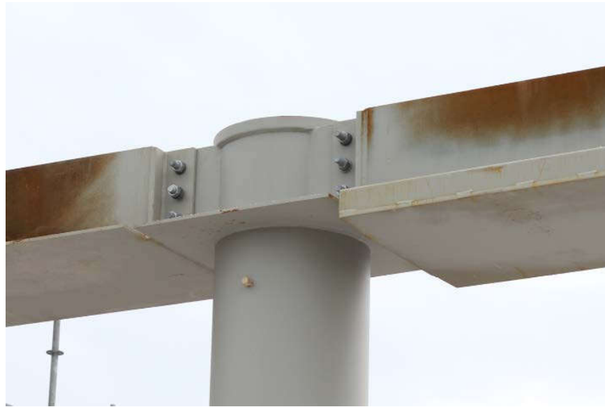
Kuva 4. Pulttiliitos pilarin reunoilla [27, s.1].
