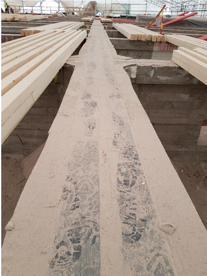
Kuva 49. Hiilikuituvahvikenauhat liimattuna niskapalkin yläpintaan
