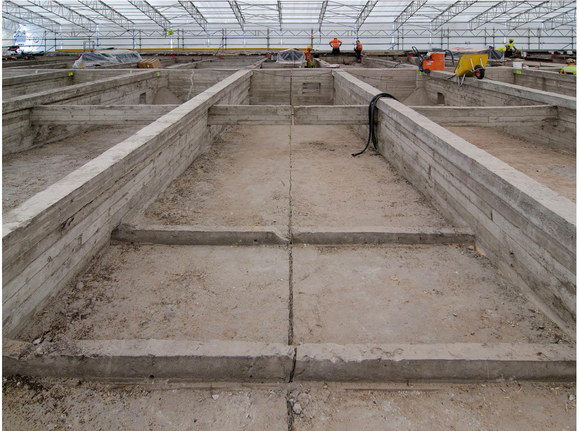
Kuva 48. Katoksen betonirakenteita purkutöiden jälkeen
