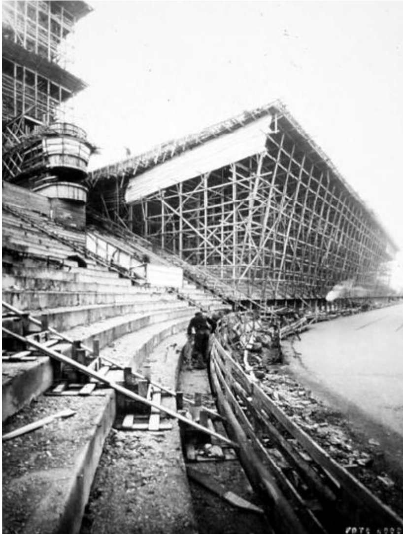
Kuva 29. Pääkatsomon katoksen muotteja ja niiden tukirakenteita [24]
