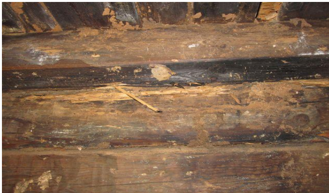
KUVIO 11. Piipunjuuresta on vuotanut vettä vaurioittaen hirsiväliseinää
