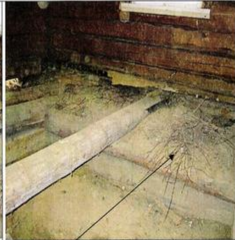
Kasvien juuret olivat tunkeutuneet sisäpuolelle.
