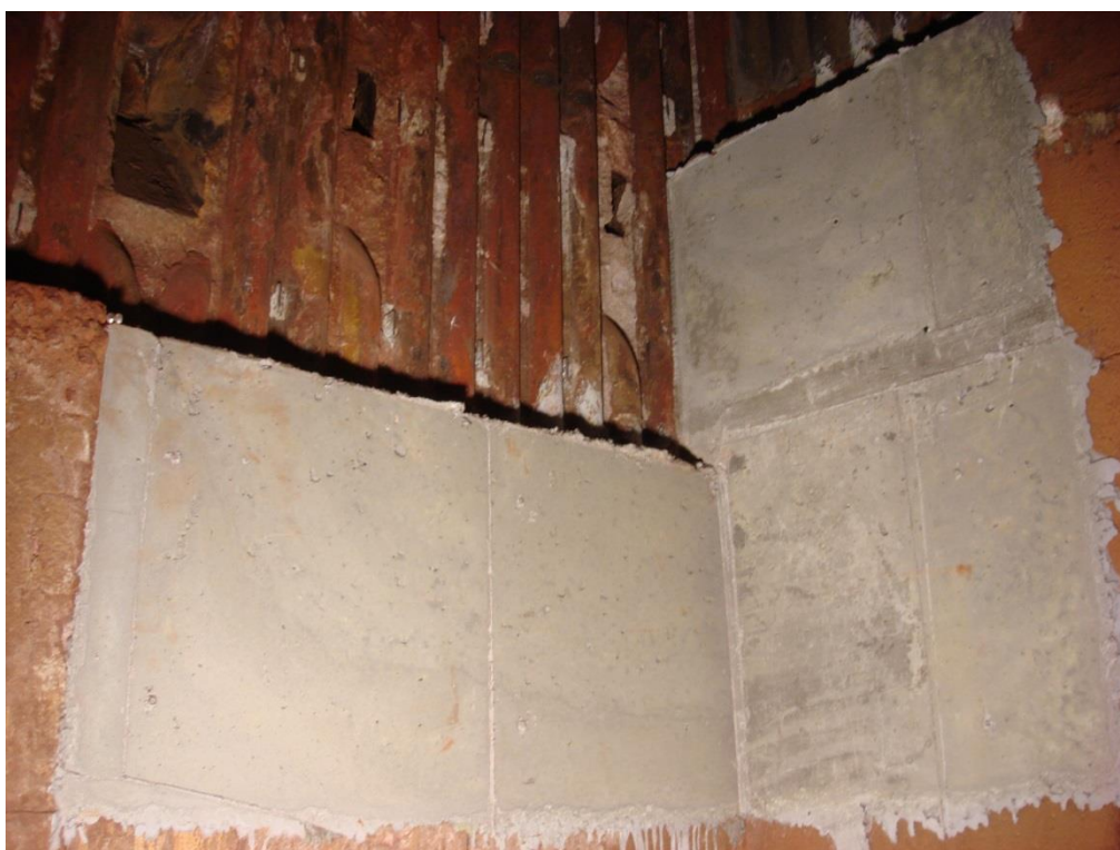
KUVA 2. Tulipesän alaosan muuraus
