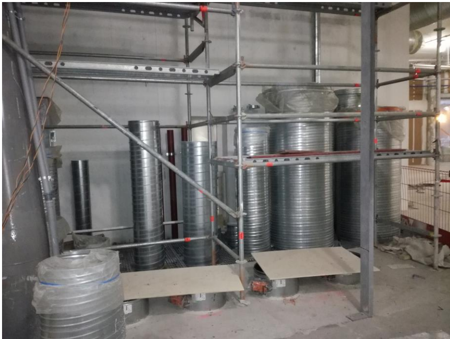
Kuva 23. Esimerkkikohteessa valittu kuilu.
