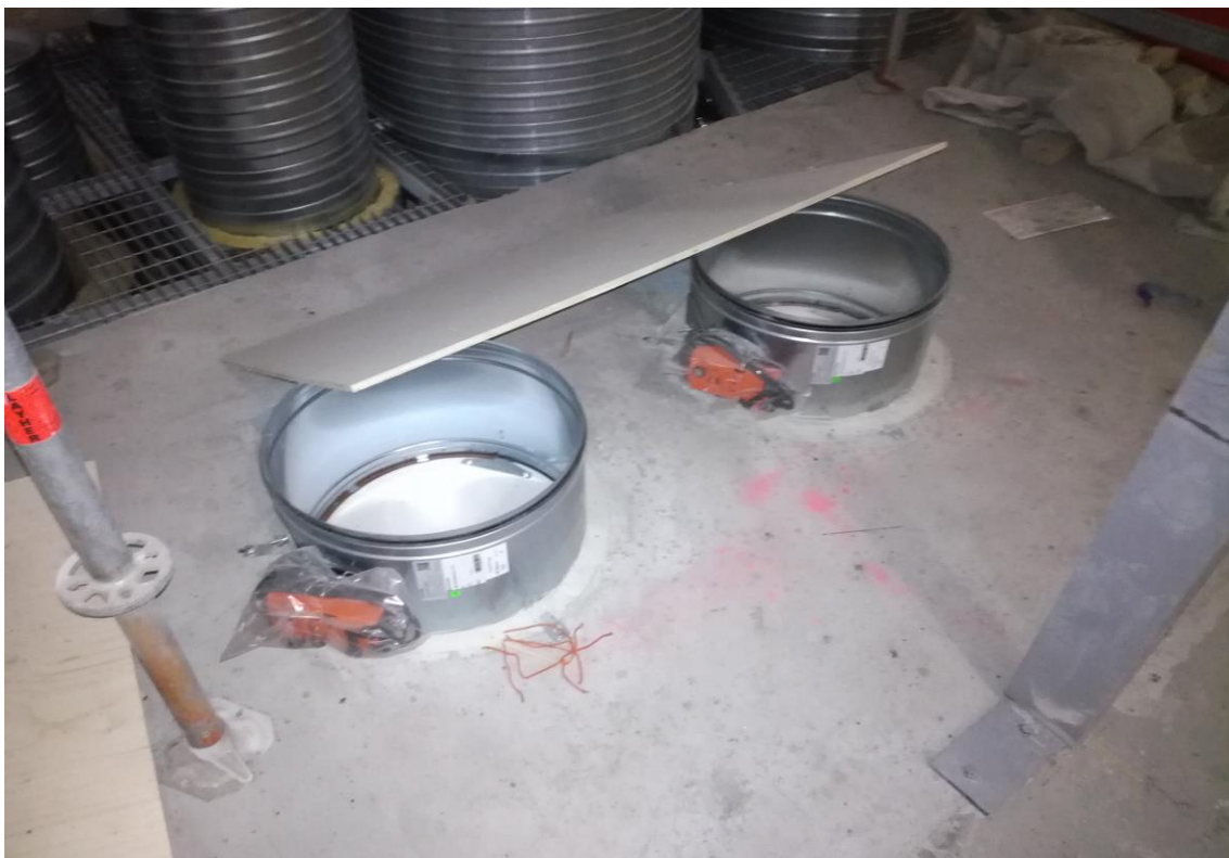
Kuva 17. CE-merkinnällä hyväksytty ETS NORD FDMB -palopelti sähköisellä toimilaitteella. (34)
