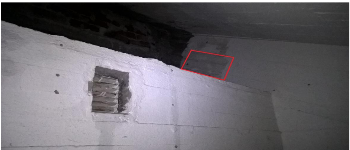
Kuva 21. Varastotilasta puuttuva reikä ja havainnollistava lämpöjohtojen reitin uudelleenluonnosdokumentti.
