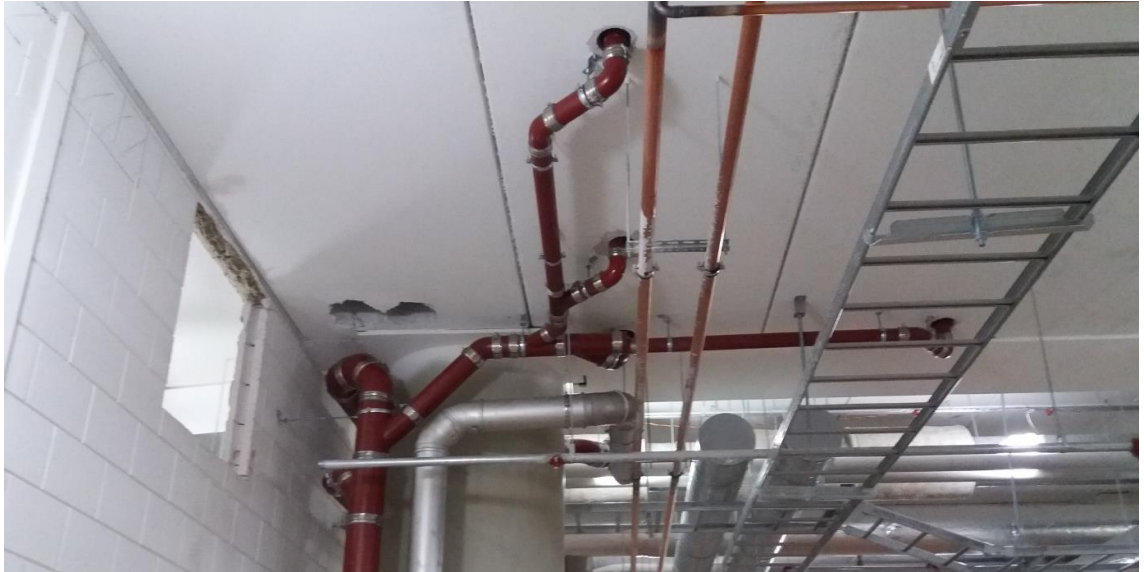
Kuva 7. Valurautaviemärointi asennettuna työmaalla ontelolaatan rajapintaan.
