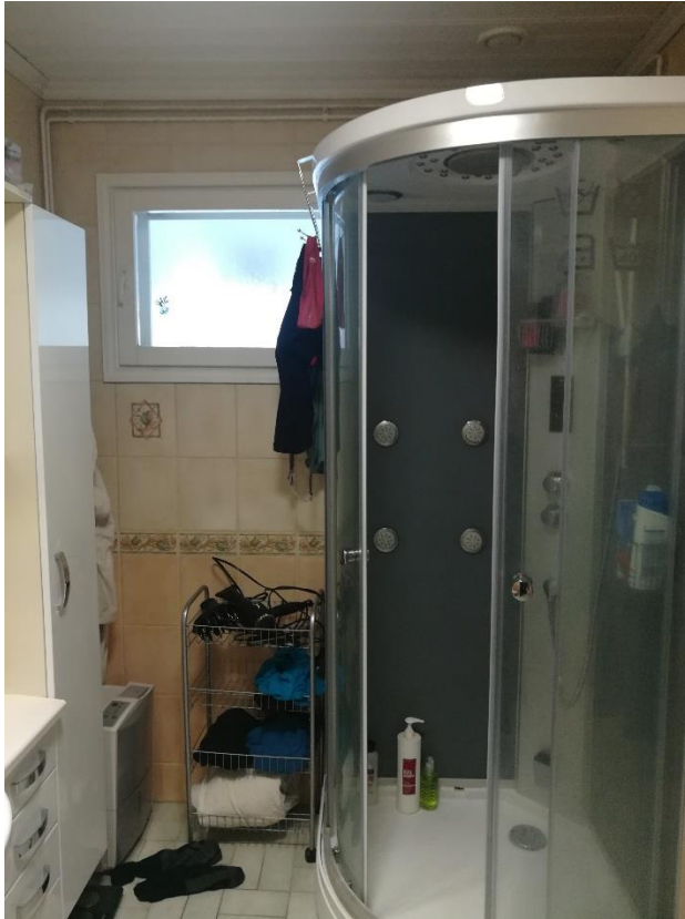
Kuva 3. Kylpyhuone ovelta katsottuna.
