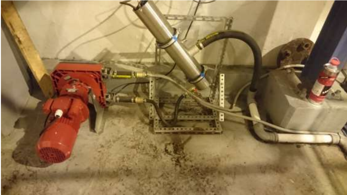
KUVA 7. PAH-yhdisteiden mittaus tehtaan jätevesilinjasta
