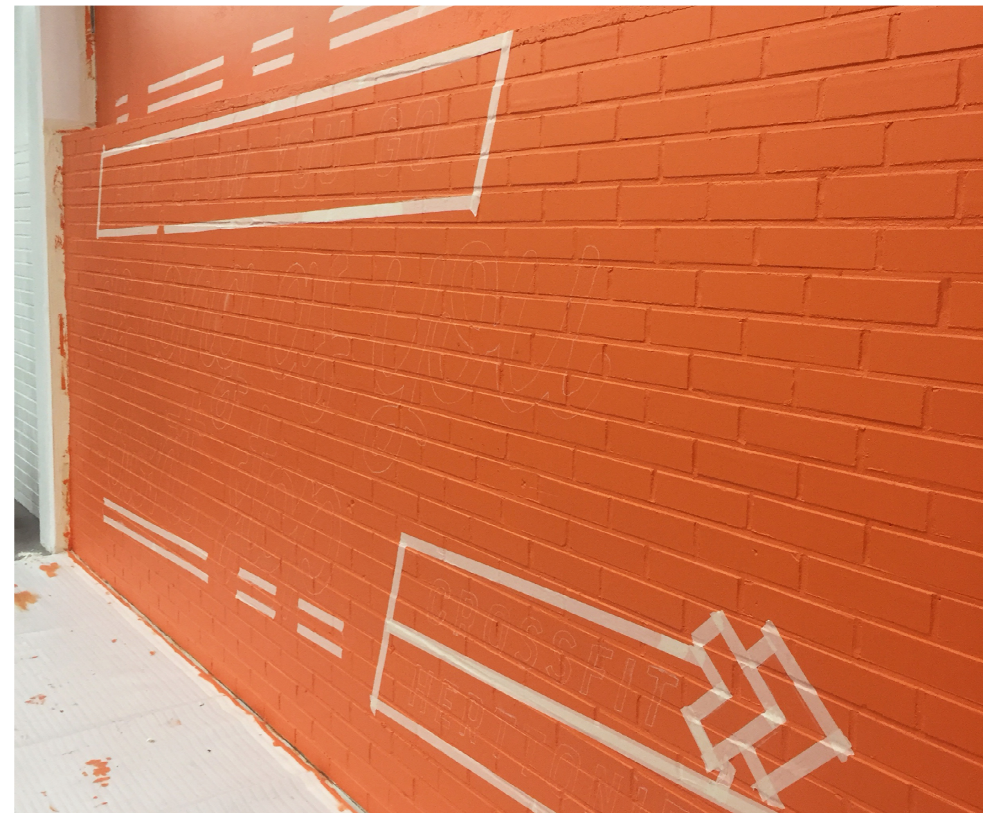
Kuva 19. Liidulla luonnostelun jälkeen teippasin maalaukseen tulevat suorat linjat maalarinteipillä.
