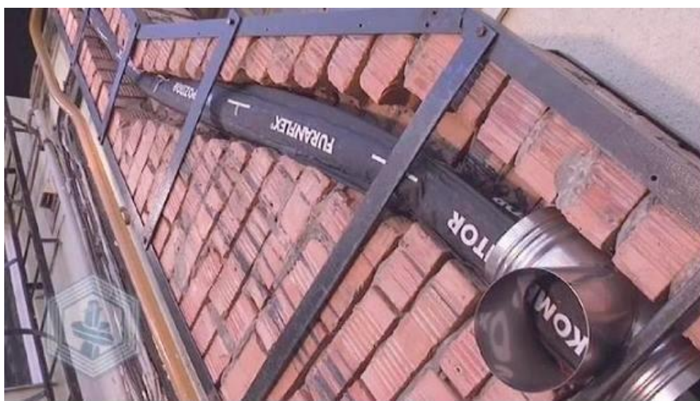
Kuva 9. Furanflex-putki asennusvaiheessa. Putki mukautuu hormin reunoja vasten.
